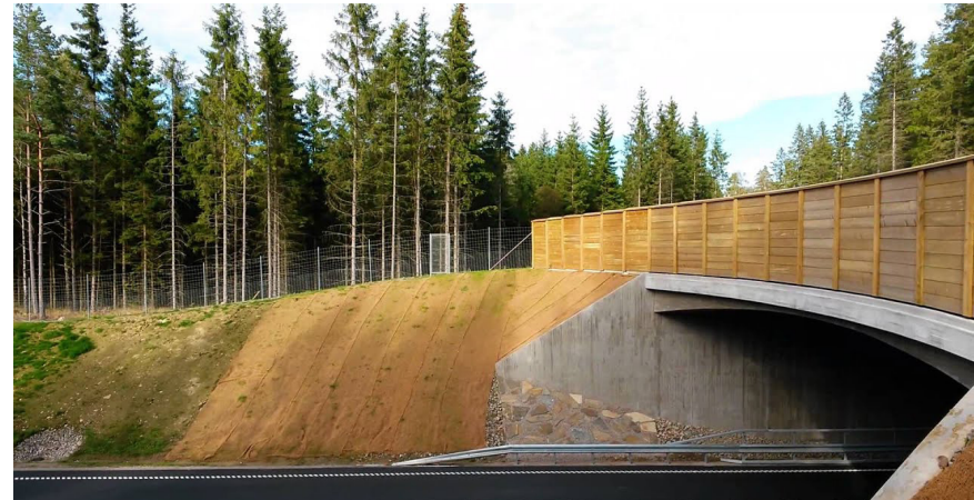
Exempel på faunabro med kokosmatta för vegetationsetablering i slänter samt faunaskärm som möter viltstängslet med rundad form.
