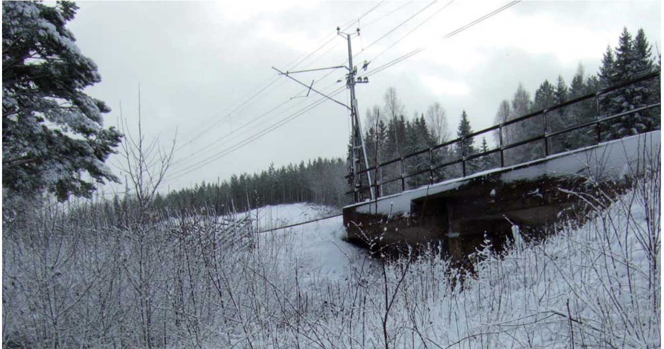
Figur 2.10 Järnvägsbro söder om Bodås, Hofors kommun
