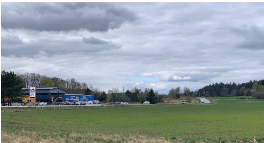
Figur 9. Industribyggnader intill väg 218 i Vagnhärad. Loxia Group.
