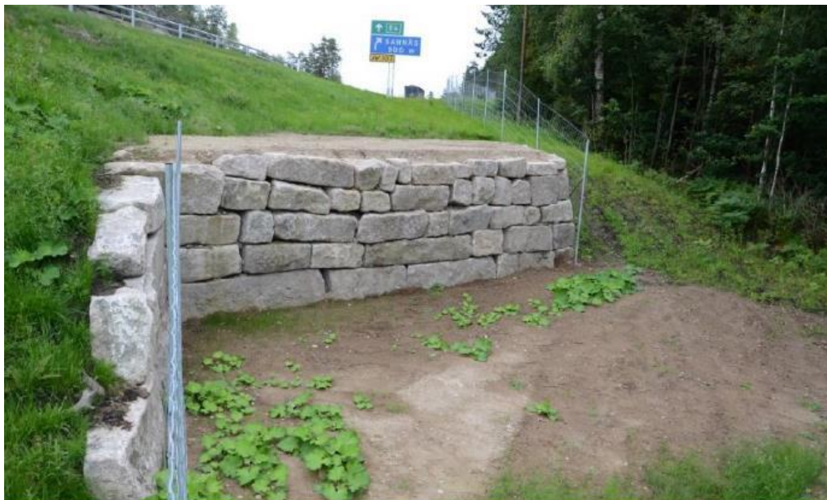
Figur 42. Exempel på viltuthopp vid E6. Källa: Pilotprojekt vilt.
