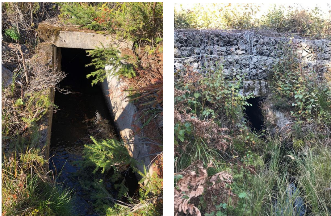
Figur 11. Trummor under spåret: Till vänster trumman i mitten av området och till höger östra trumman.
