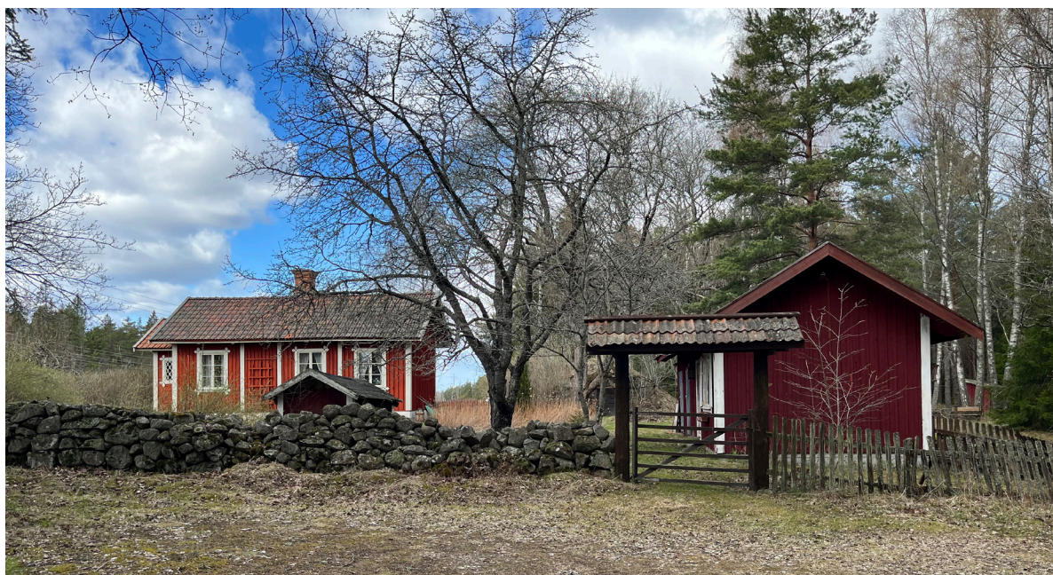
Figur 84. Söderby banvaktstuga med tillhörande ekonomibygnad, trädgård och gärdesgård.
