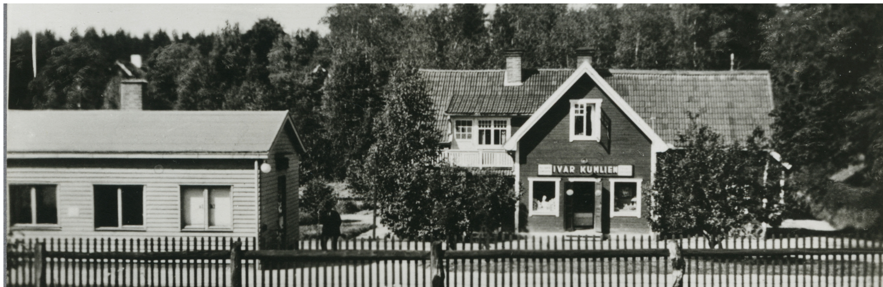
Figur 82. Den funktionalistiska stationsbyggnaden i Alsike och affären. Bilden är beskuren. Okänt årtal. Järnvägsmuseet.
