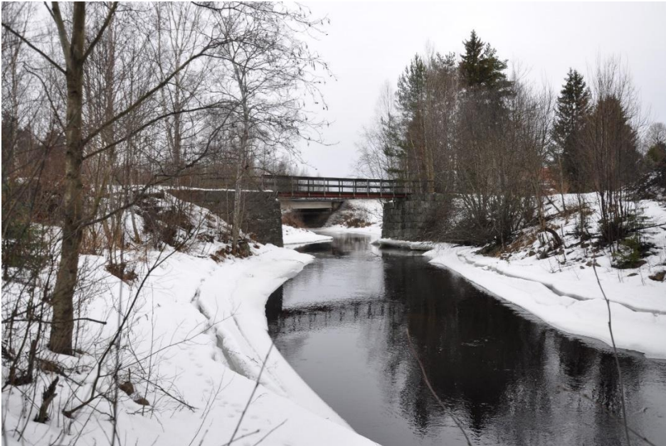
Bild 2.1 Galvån/Rösteån sett mot väster, med en smal gångbro i förgrunden.
