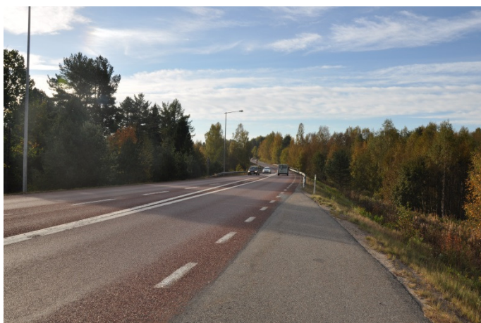
Figur 12 Västra sidan av vägbron/väg 83 sett från norr.
