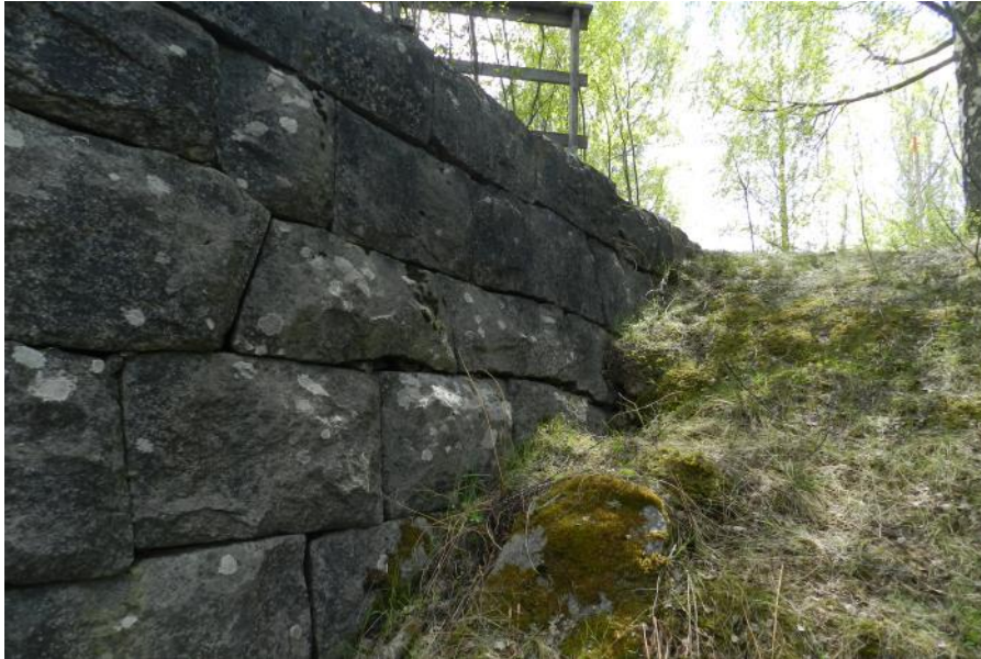
Figur 21 Västra sidan av stödet.
