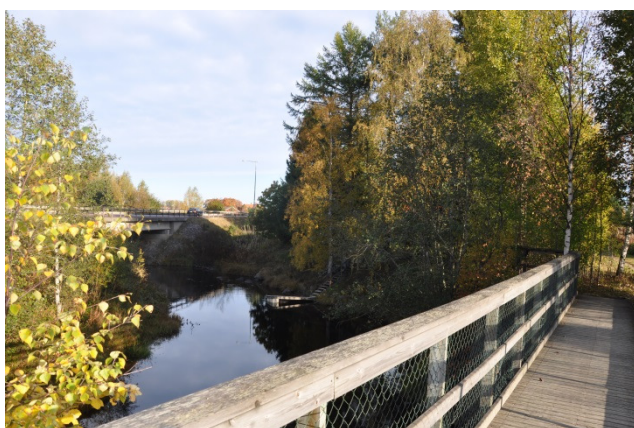
Figur 15 Vy från befintlig spång. Väster om bron skimras väg 83.
