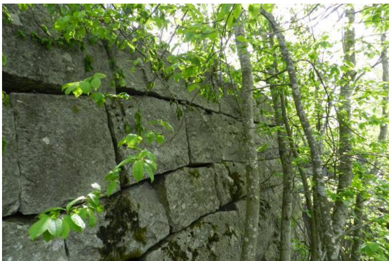
Figur 29 Västra sidan av stödet.
