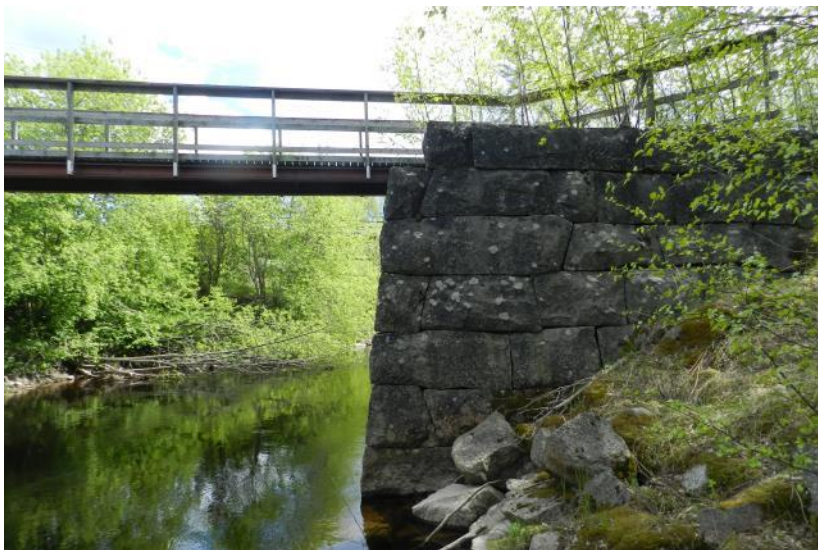
Figur 13 Västra sidan av det södra stödet.
