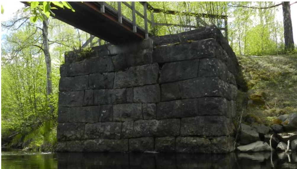
Figur 20 Norra sidan av stödet.
