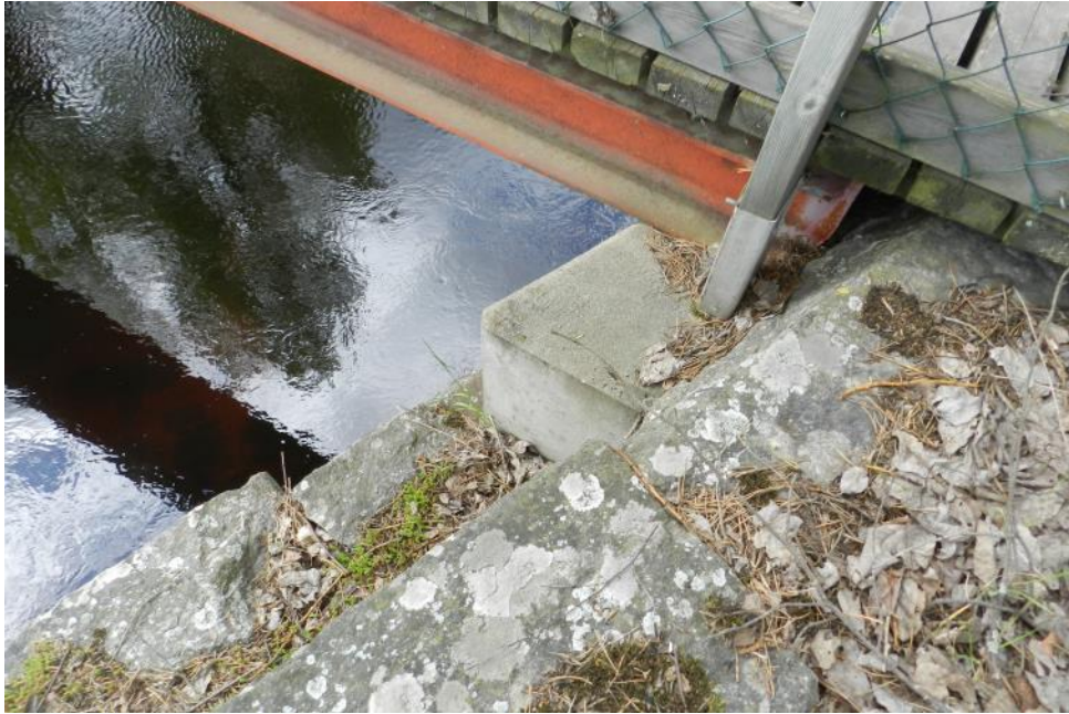
Figur 4 pågjuten lagerpall direkt på stenraderna.
