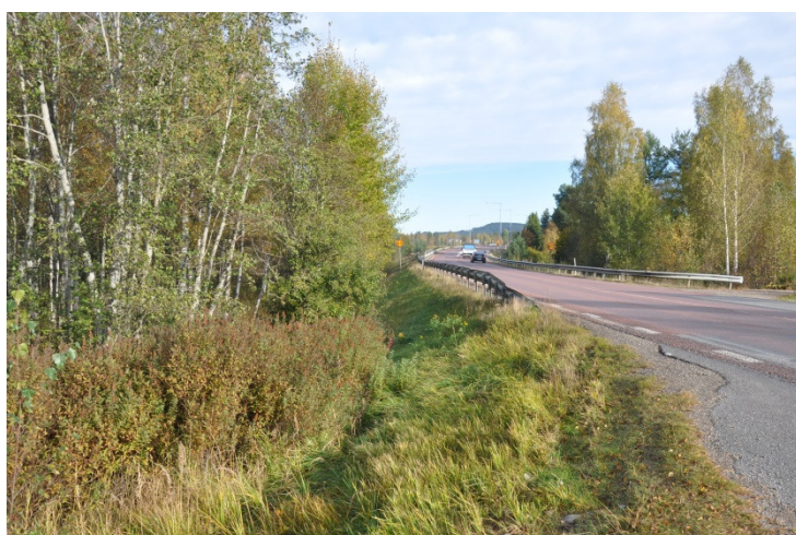
Figur 10 Västra sidan av vägbron/väg 83 sett från söder.
