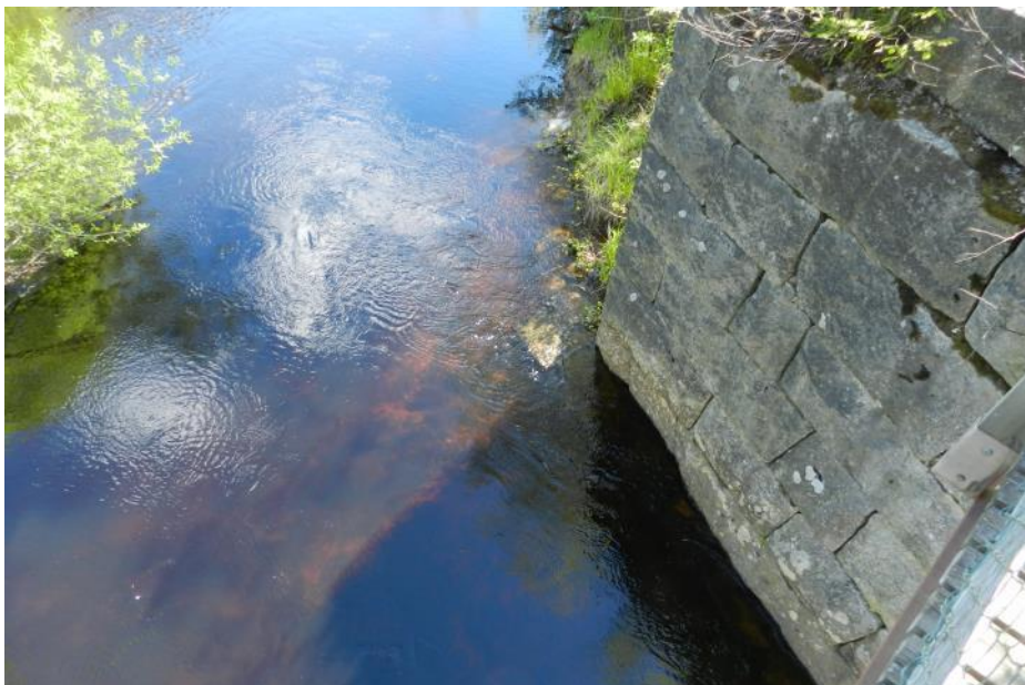
Figur 12 Stenlandfäste på södra sidan.
