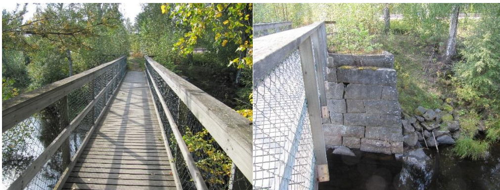
Figur 12 Befintlig gång- och cykelbro
