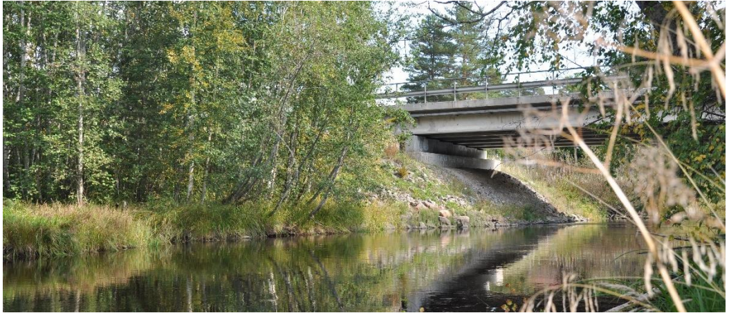
Figur 14 Bro med konstruktionsnummer 21-147-1. Vy från Rösteåns strand
