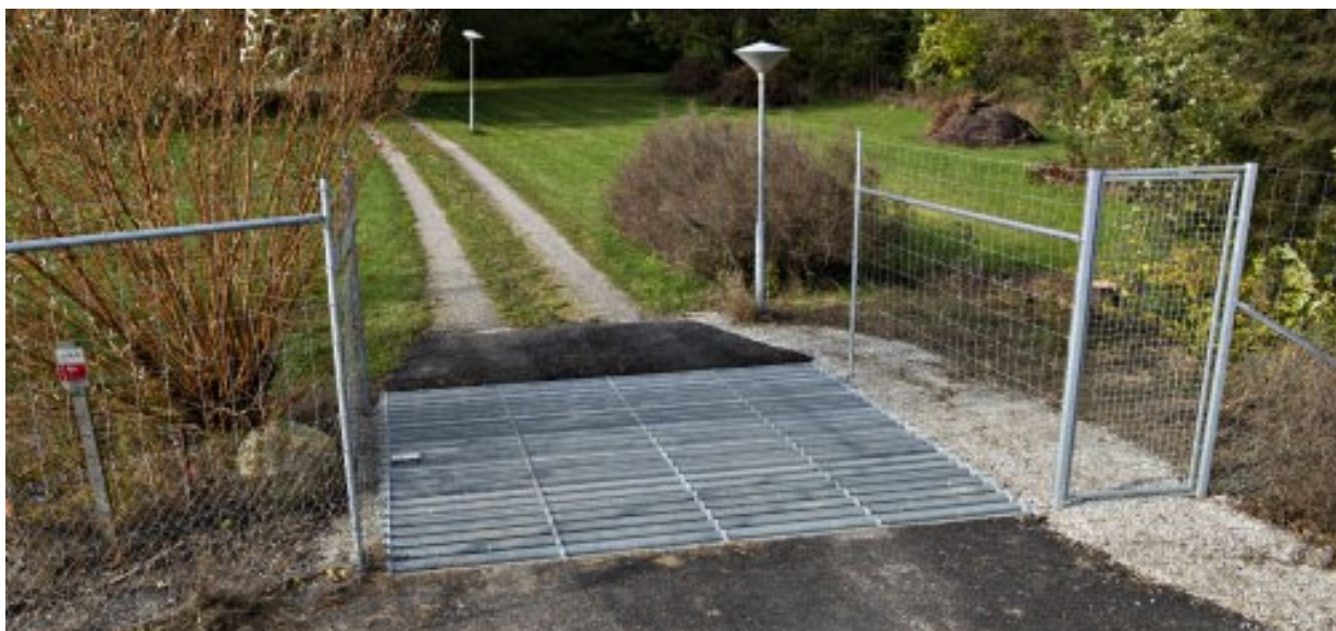
Figur 22. Viltstängsel anslutet till färast vid enskild väg med anslutande sidogrind för exempelvis passage med husdjur. (LHFENCE, 2020).
