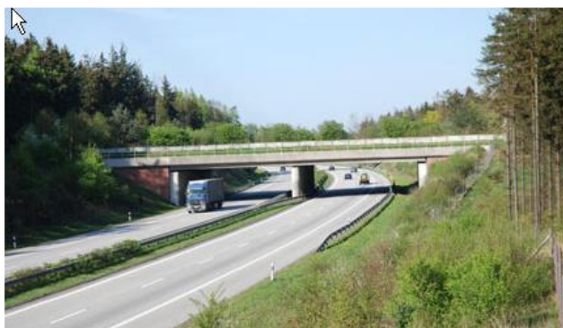
Figur 18. Faunabro med vegetation. Foto Trafikverket.
