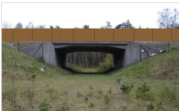
Figur 20. Exempel på faunaport med naturligt marktäcke. Foto Trafikverket.
