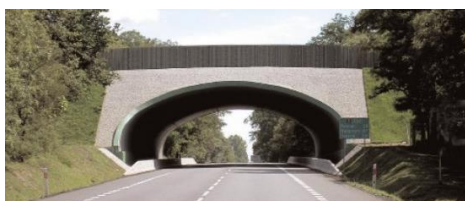
Figur 7. Exempelbild på stålvalvsbro (SuperCor).
