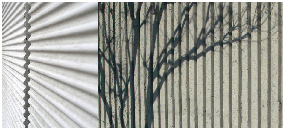
Exempel på mönstrad betong med reliefverkan.
