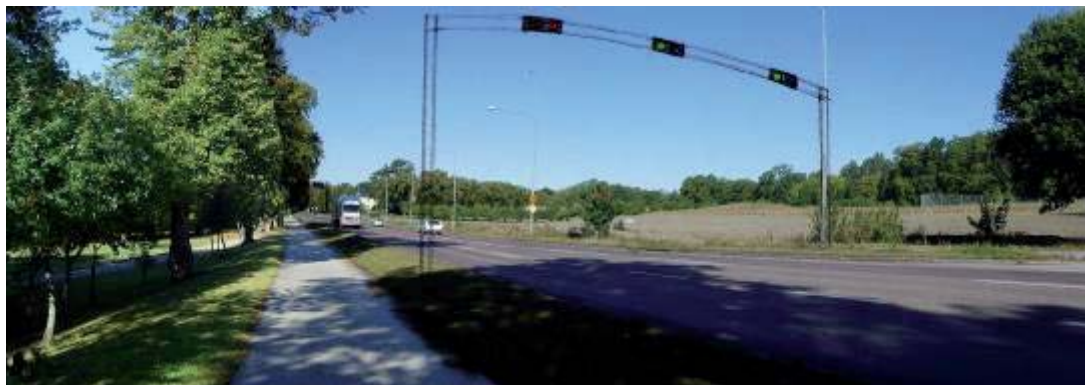
Figur 5.8 Fotomontage, exempel på portal med ljussignaler för reversibelt samtrafikkörfält vid Drottningholms slottspark, HÅ1 (Landskapslaget, 2007)
