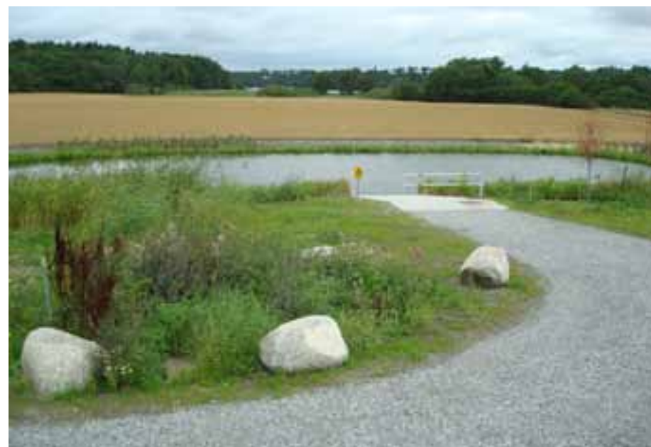
Figur 5.29 Dagvattendamm på Kärsö
