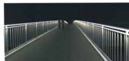
Exempel på belysning placerad i räcket. Genom att placera belysningen i räcket minskar reflexerna i vattenytan och bron blir mindre iögonfallande från omgivande landskap. Bildkälla: Belysning av broar och portar, Arkus & Vägverket.
