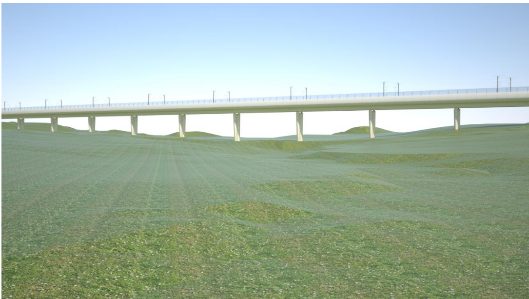
Figur 16 - Punkt 4 - vy från Trosaåns fåra, mot sydost. Bro med 40-metersspann.
