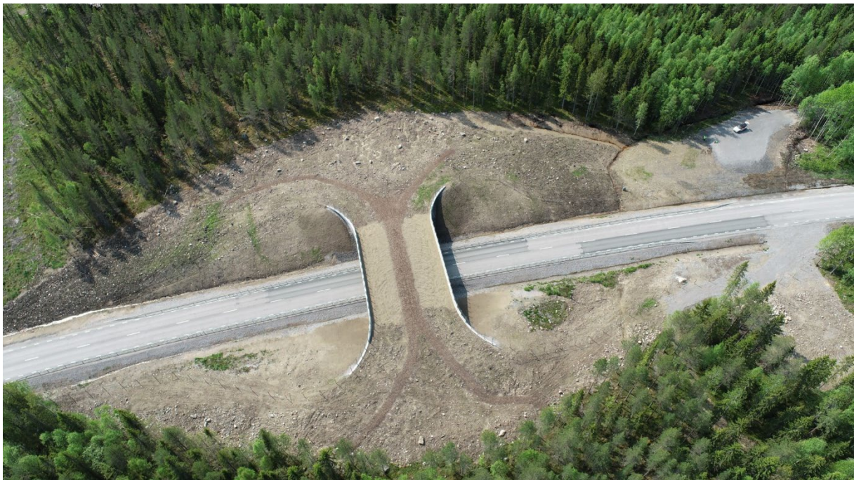
Figur 15. Exempel på faunabro. Bilden visar en faunabro över E4 Bredviksheden under byggtiden.
