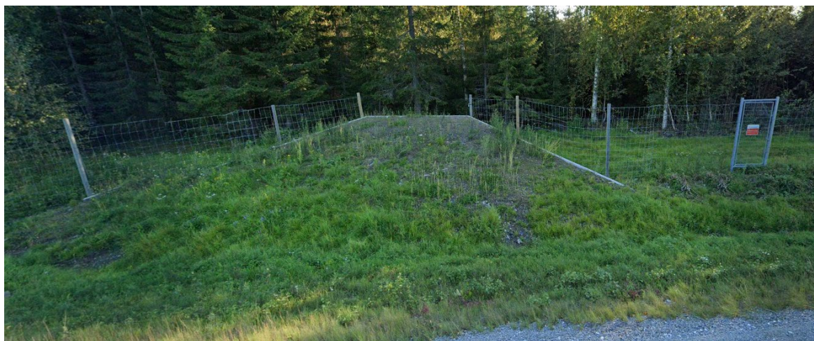
Figur 14. Exempel på viltuthopp på E4.
