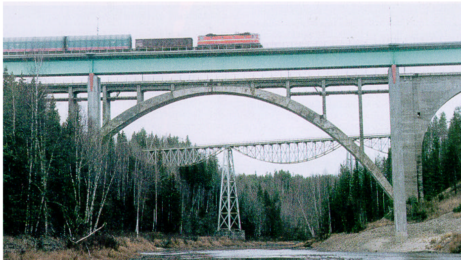
Figur 10 På detta fotografi ses Talbergsbroarna över Öre älv. Här kan man jämföra tre olika typer av brokonstruktioner. Den äldsta är ett nitat fackverk invigd 1891, därefter kom betongbågbron som invigdes 1919 och till sist den raka stålbalken som invigdes 1994, Hedin (1997)
