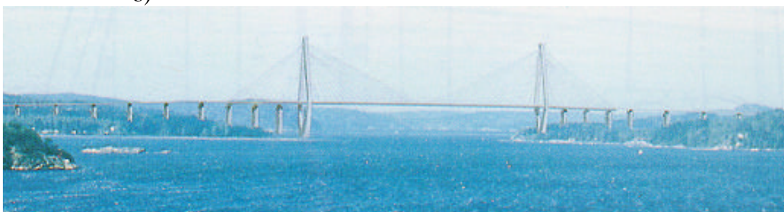
Figur 2 Fotomontagebilder från Sunningesundsbron som byggs vid Uddevalla. a) Alternativ med lådbalkbro i betong. b) Alternativ med en pylon och snedkablar. c) Alternativ med två diamantformade pyloner och snedkablar, det vinnande alternativet (bilder hämtade ur MKB(1992))
