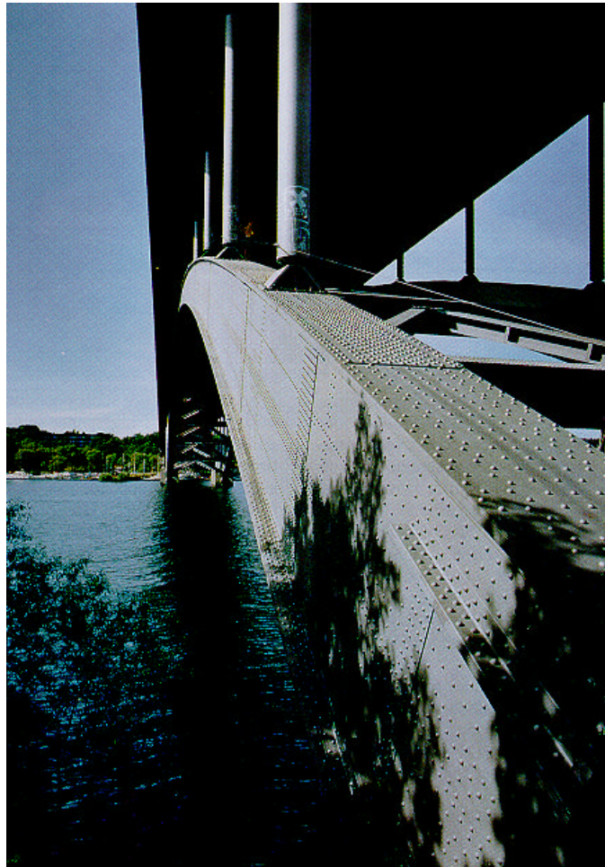
Figur 9 Västerbrons stålbåge byggd med nitade stålplåtar, Kallstenius (1996)
