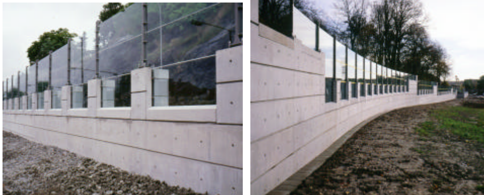
Figur 6 Bullerplank tillverkade med titandioxid som pigment i infärgad betong.
