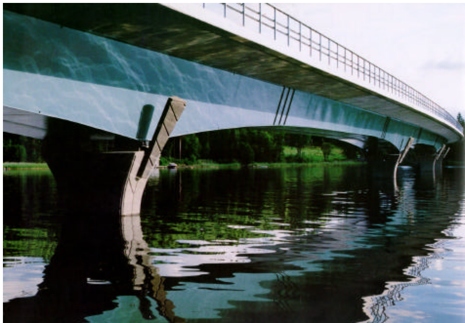
Figur 11 Den votade stållådan som bär E4:an över Majorsviken. De speciella relieferna smyckar varje anslutning mellan blå stållåda och pelartopp, Ottander(1997)
