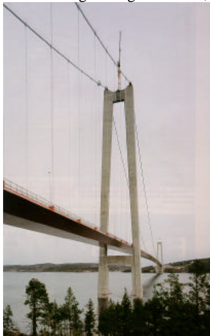
Figur 1 Höga Kusten-bron, ett unikt projekt med en unik bro som fått pris för att hänsyn har tagits till bronns gestaltning
