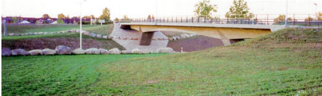
Figur 4 Nyare betongbro som visar ett exempel på hur hänsyn tagits till gestaltningen, Vägverket Konsult (1999)
