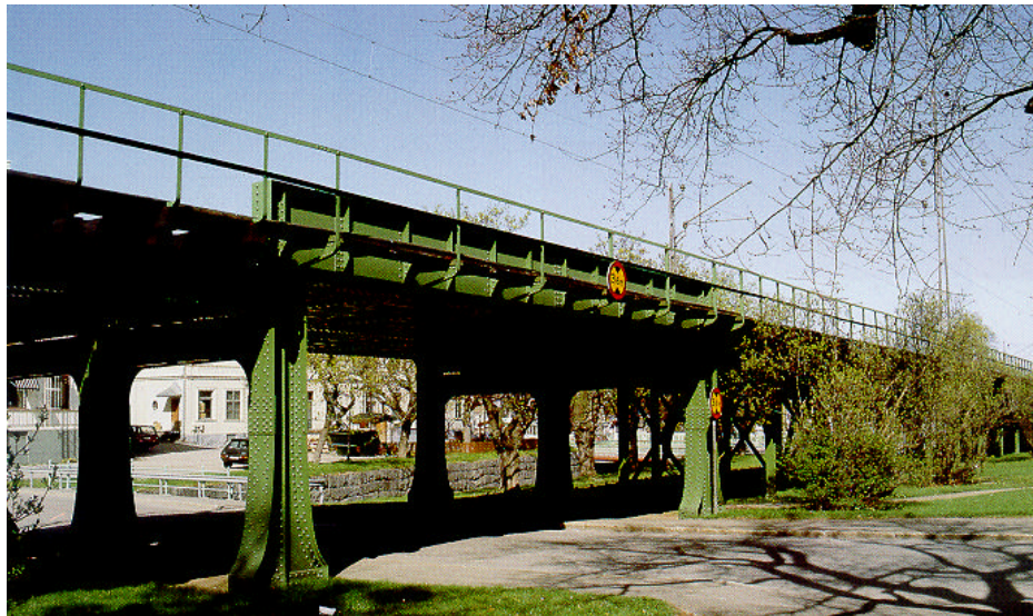
Figur 8 Järnvägsbro i Söderhamn som exempel på äldre nitade järnbroar, Kjessel m fl. (1991)
