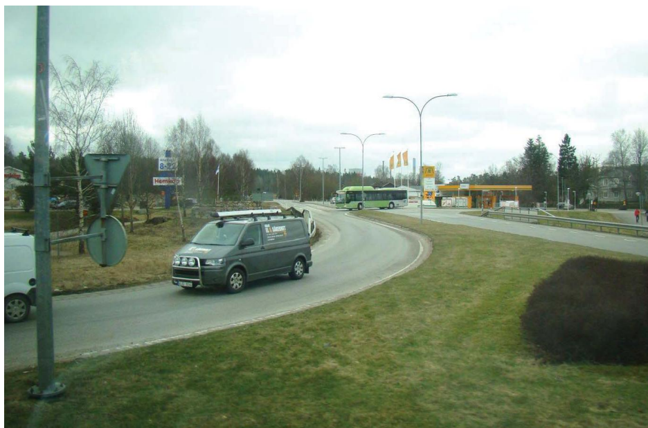
Figur 22: Mittrefuger och armatur ger ett storskaligt intryck vid Fagrabäcksrondellen, vy mot söder och väg 27.
