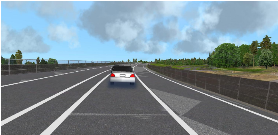
Figur 27: Genomsiktliga bullerplank på södra delarna av väg 27 medför utblickar och underlättar orienterbarheten.
