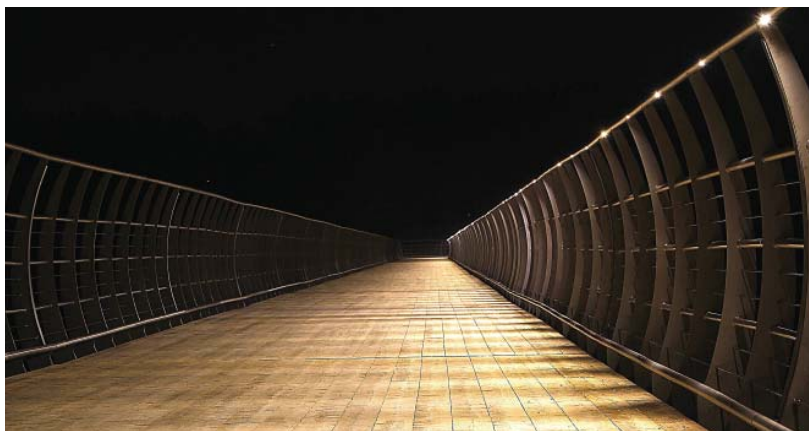
Figur 35. Exempel på infälld led-belysning i broräcke som riktats nedåt mot gångbanan.
