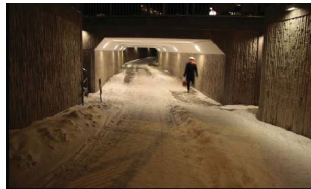
Figur 70. Exempel på strukturbetong i GC-port.
