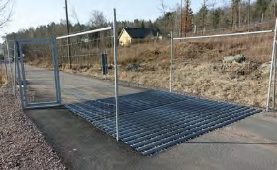
Figur 4 Färist vid Äpplekullavägen vid Källered.
