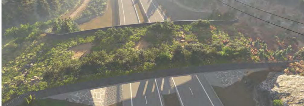
Figur 32 Bild från 3D-modell, vy över E6 i riktning mot Kungsbacka. Till vänster i övre hörnet skymtas den skogsväg som förlängs så att ansvariga för drift av ekodukten kan ta sig till bron. Faunastängsel skymtar i vänstra övre hörnet. Bild: TEMA AB.
