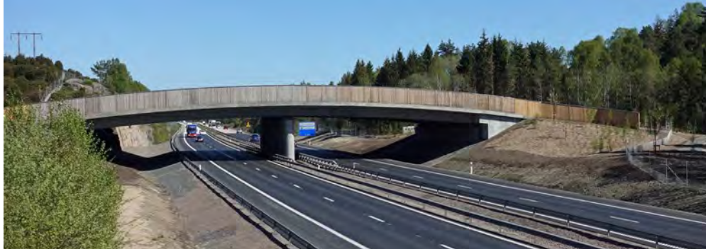
Figur 7 Vy från E6 mot norr för nybyggd ekodukt, maj 2018. Stor vikt har lagts på gestaltningen av bron. Faunaskärmen i trä blir gråare med tiden och smälter bättre in i landskapet.
