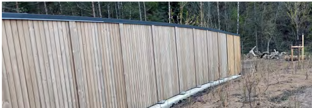
Figur 9 Faunaskärmen består av 2-meters sektioner som kan bytas ut vid skada.
