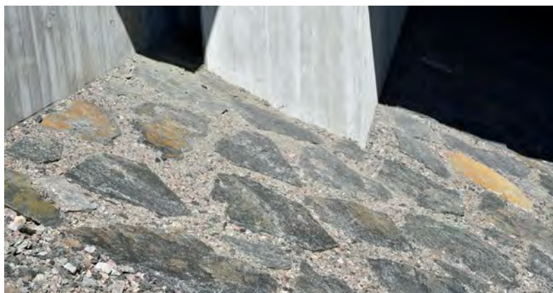
Figur 29 Detalj från stensättning i vägslänt under bron.
