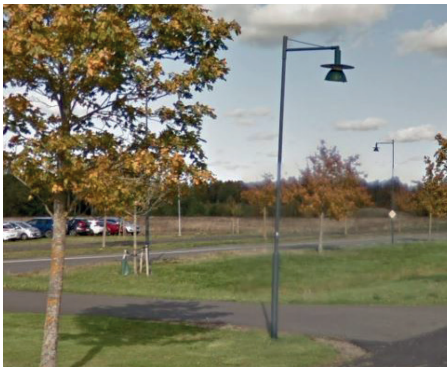
Bild 19. Befintlig belysningsarmatur vid gång- och cykelväg längs med Nolhagavägen. (Google)
