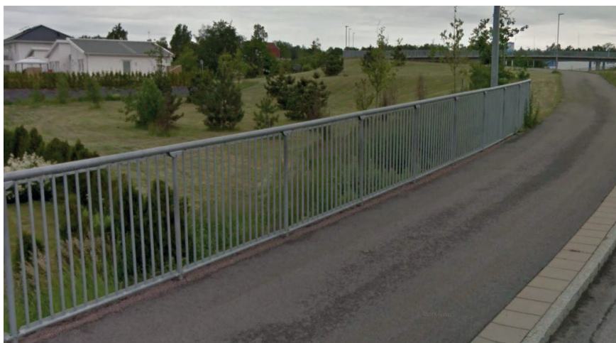
Bild 18. Exempel på gång- och cycleräcke med genomgående överligger och spjälgrind. (Google)
