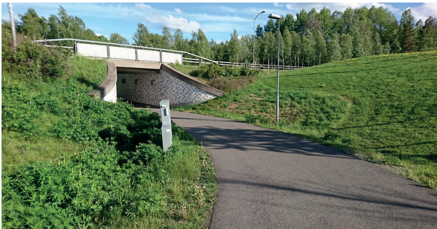
Bild 4. Befintlig gång- och cykelport som tas bort.
