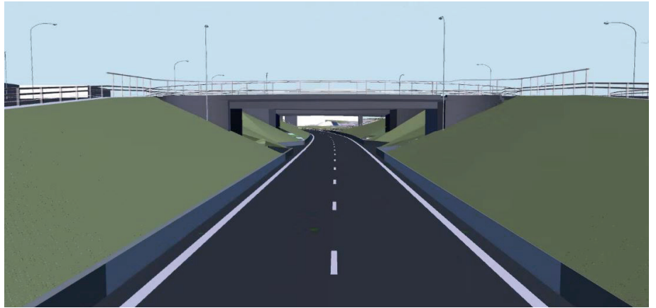
Bild 13. Vägbroarna utformas med stor spännvidd för genomsikt.
