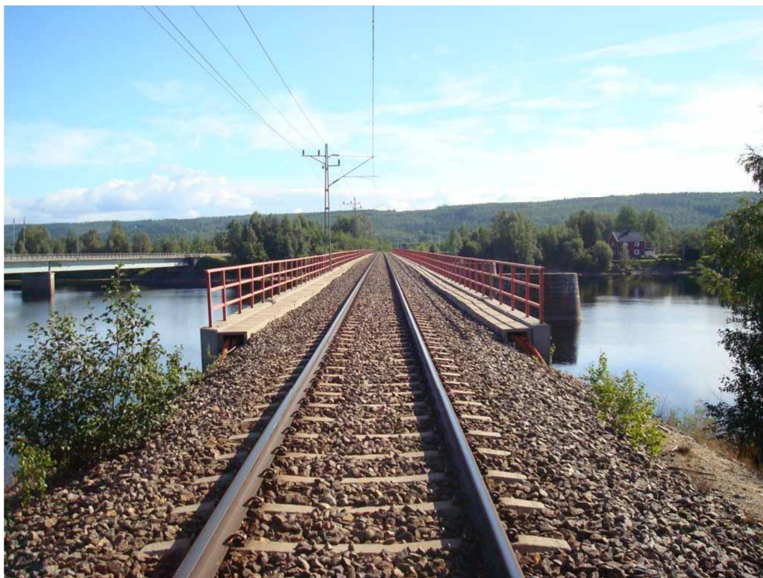
Figur 5. Befintlig järnväg på balkbro över Vindelälven vid Vännäsby, med befintlig vägbro (E12) till väster och gamla brostöden till höger. Foto taget från västra sidan älven.
