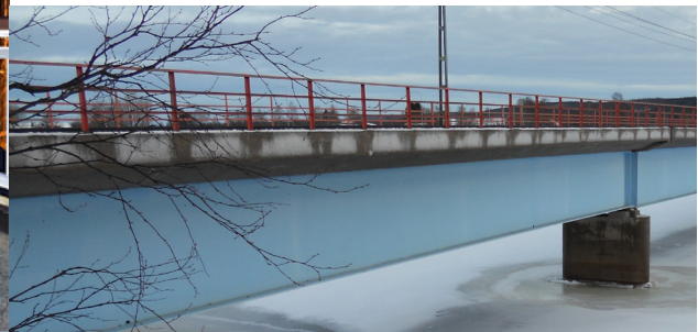
Figur 13. Nedan färgsättningen på den nya järnvägsbron.
