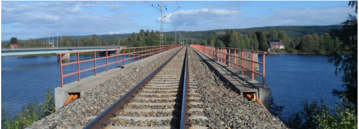
Figur 3. Befintlig järnväg på balkbro över Vindelälven vid Vännäsby, med befintlig vägbro (E12) till väster och gamla brostöden till höger.
