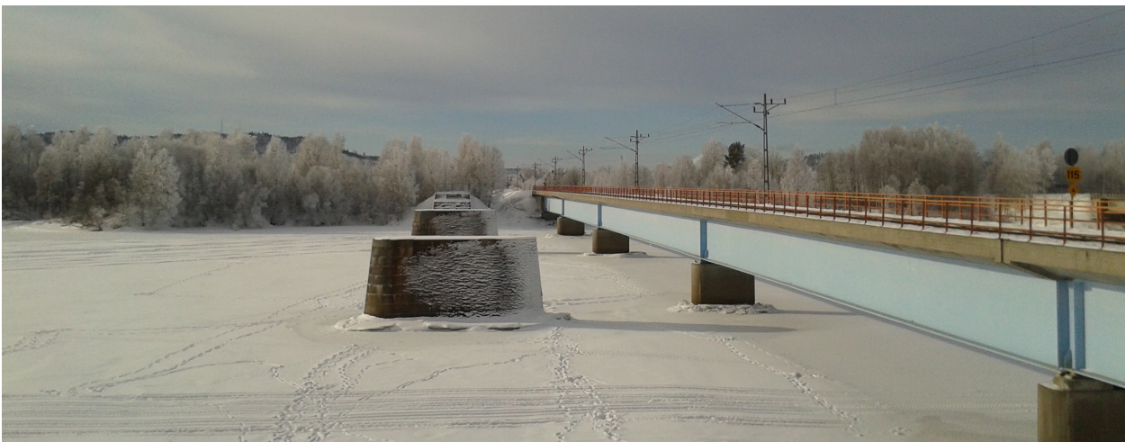
Figur 1. Den nya järnvägsbron med de bevarade brostöden och landfästena från den gamla järnvägsbron strax söder om.
