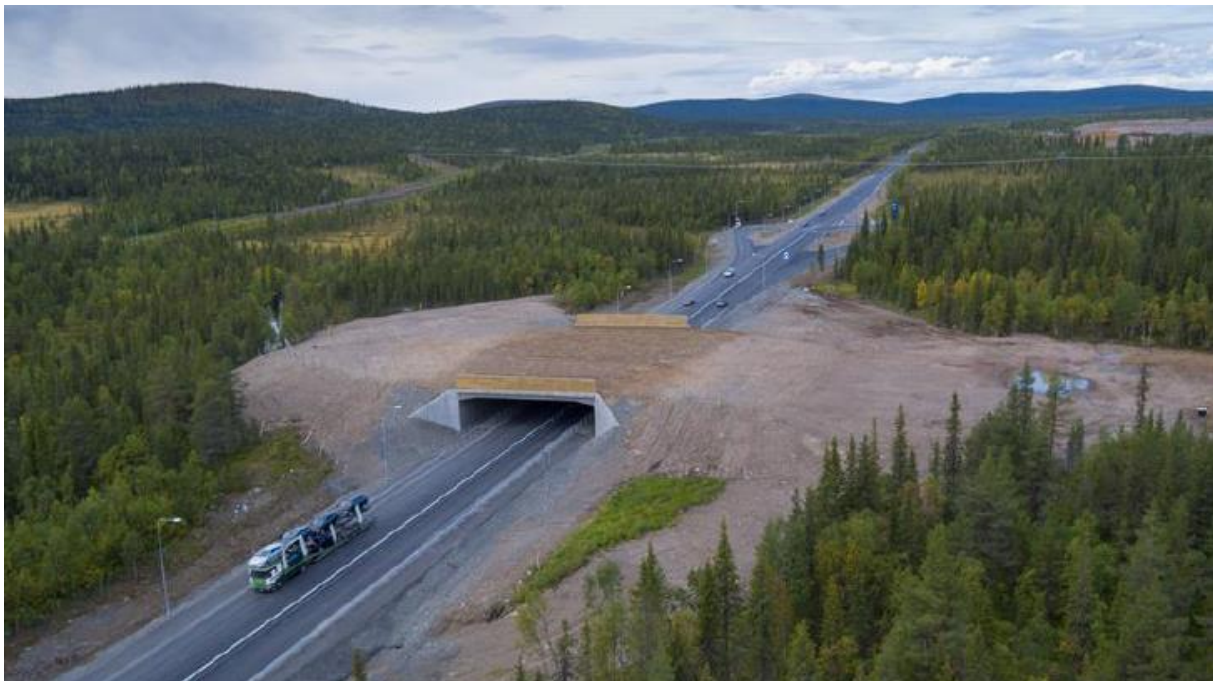
Figur 12 Exempel på en planskild faunapassage och visar ej fastställd utformning. Bilden visar en faunabro över E10 Svappavaara (foto från BatMan).
