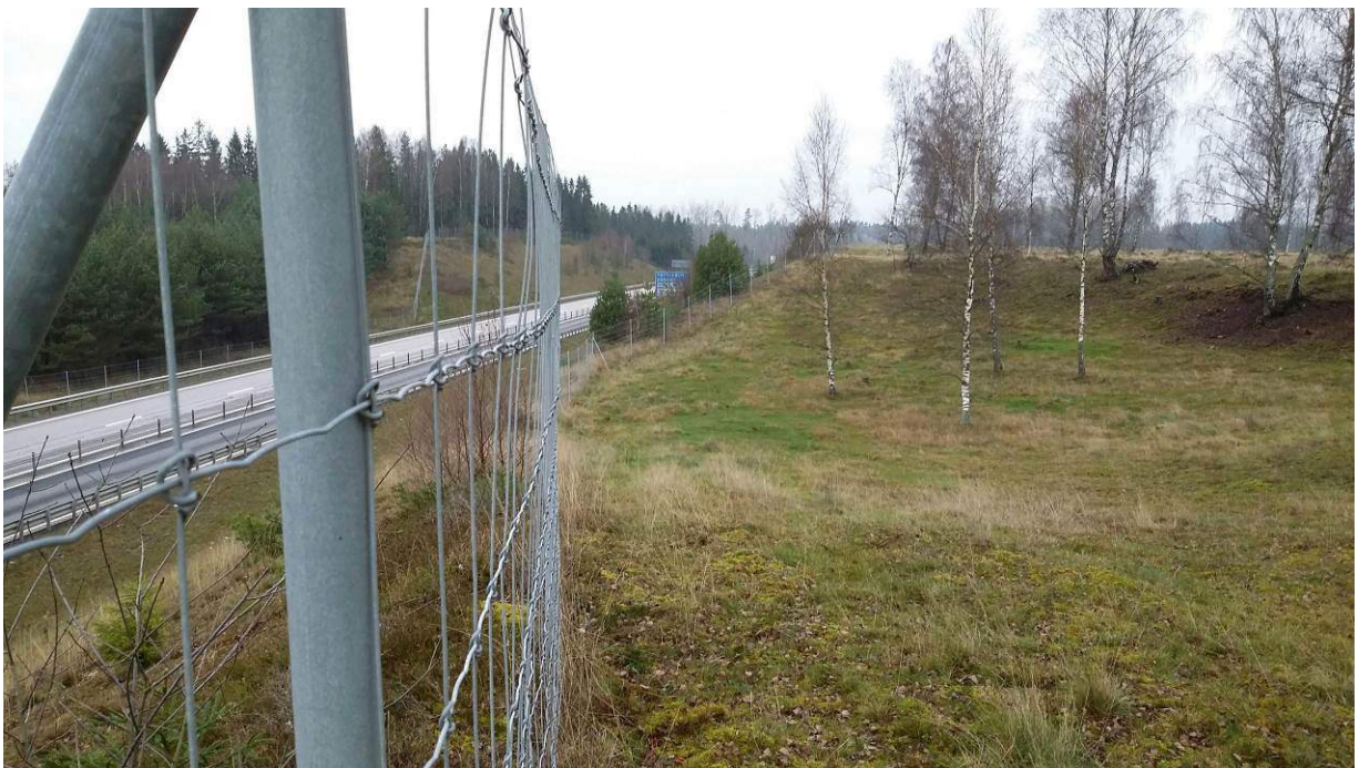
Figur 34. Objekt 20. En av de två mindre ytor som berörs på den östra sidan av väg E4 vid en arbetsbredd på 20 meter räknat från vägbanans kant. Foto mot norr.
