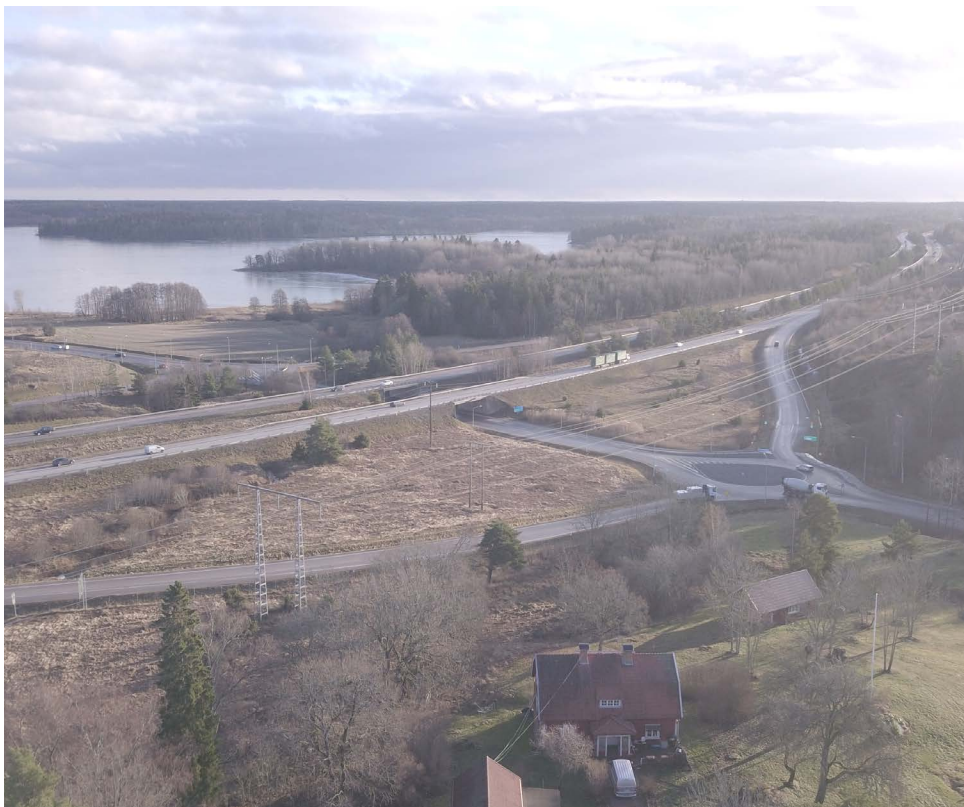
Figur 32. Vy från Ar mot Trafikplats Brunnby.
