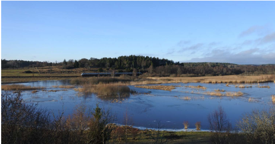
Figur 67. Befintlig järnvägs passage genom Trunsta träsk.
