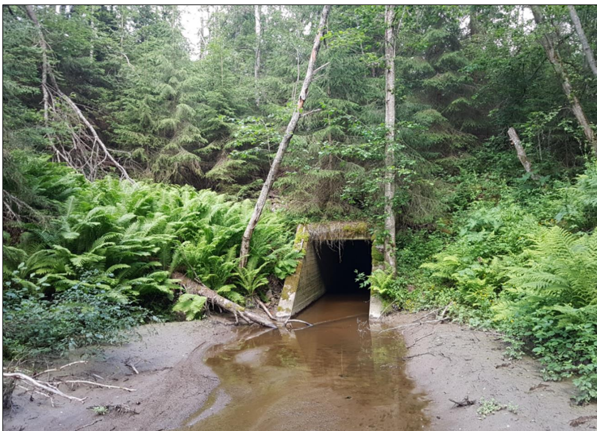
Figur 10. Utloppet av den förlängda stentrumman i Brödlösbäcken, norra Östanå.
