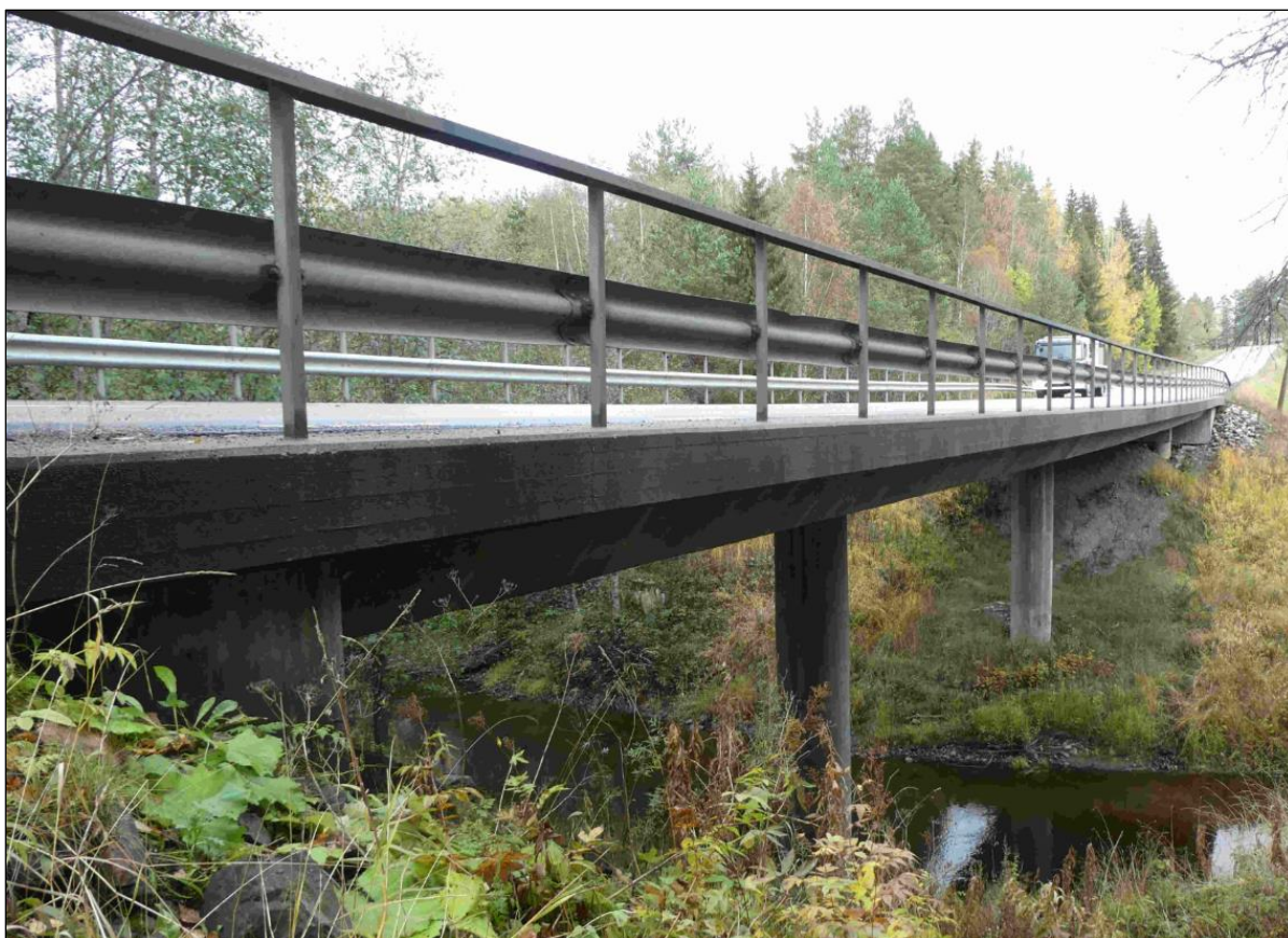
Figur 9. Bro över Sättnån vid Östanå/Tösta. Bild från "BaTMan" vilket är en förvaltningsdatabas för broar, tunnlar och andra typer av byggnadsverk.
