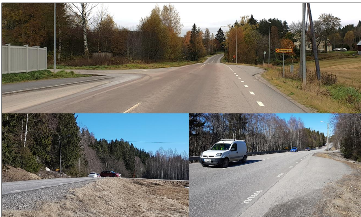
Figur 6. Tre större anslutningar till väg 86. Överst; Korsning mot Kvarsätt vid vägplanens start, foto mot nordväst. Nederst till vänster: Korsning mot Oxsta ligger på ett krön, foto mot söder, Nederst till höger: Korsning mot Tösta skymtar mellan busshållplatsen i förgrunden och bro över Selångersån/Sättnaån i bakgrunden. Foto mot norr.
