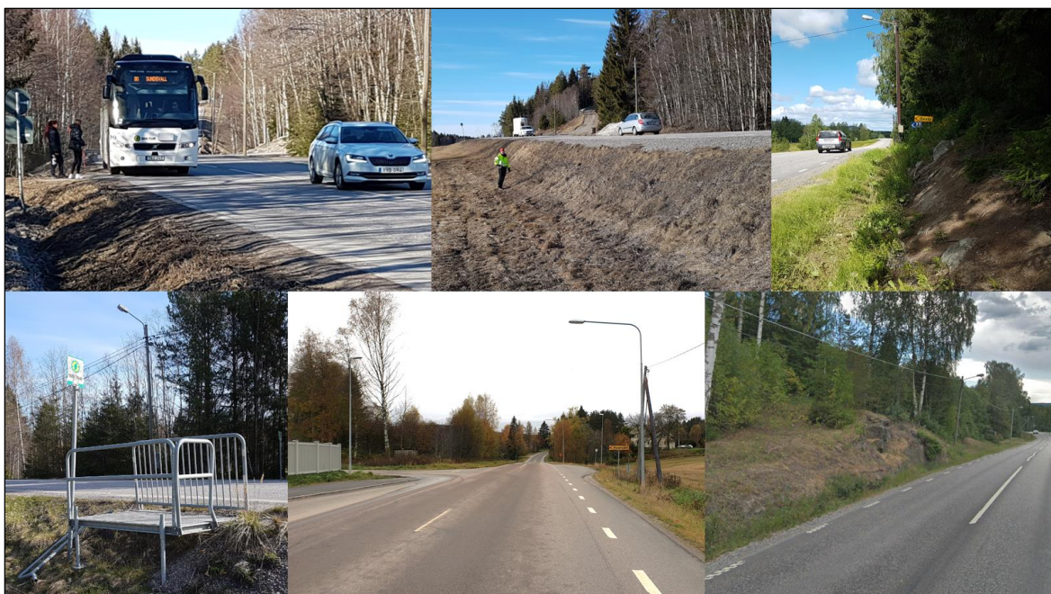
Figur 5. Miljöer längs väg 86. Busshållplatserna håller en låg standard. Bitvis är vägbanken hög och brant och oeftergivliga föremål finns nära vägkanten Siktförhållandena är dåliga på vissa sträckor.
