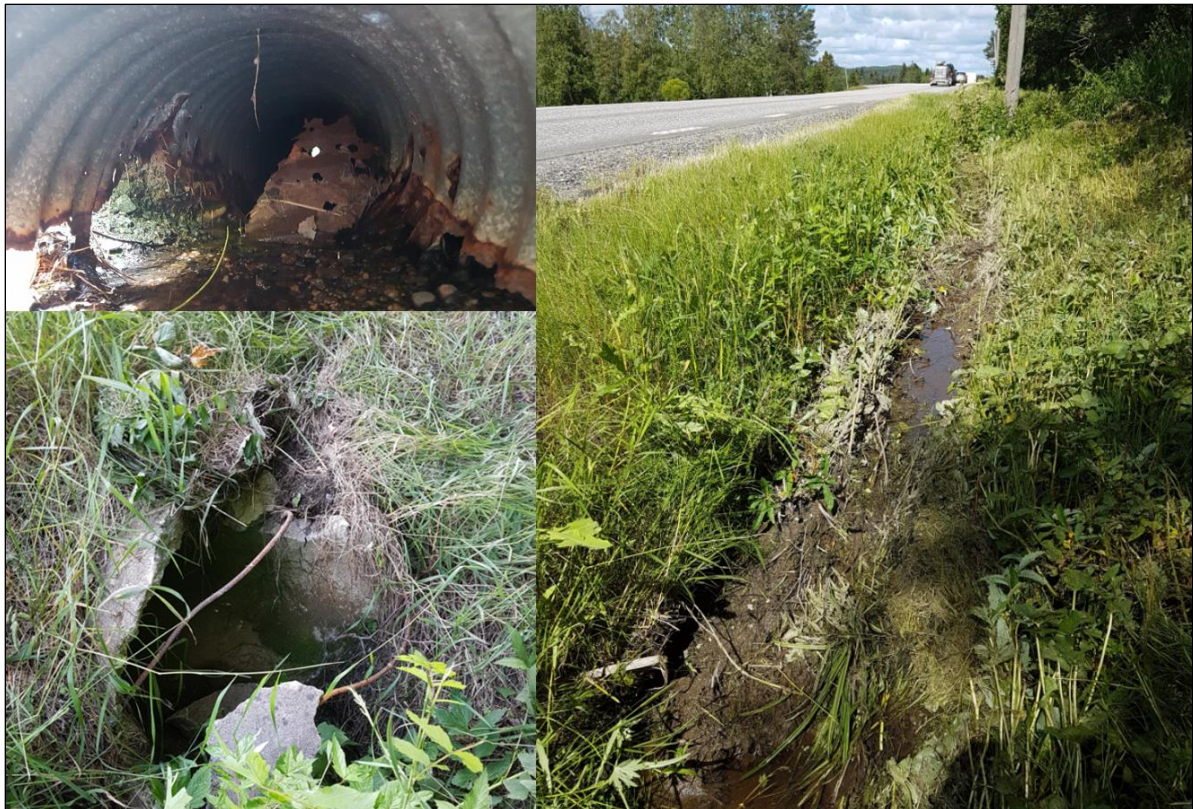
Figur 11. Befintligt väggavvattningssystem i form av trummor är generellt i dåligt skick. Genomrostad plåttrumma och betongtrumma med omfattande skador till vänster. Förekommande öppna diken är längs långa sträckor grunda.
