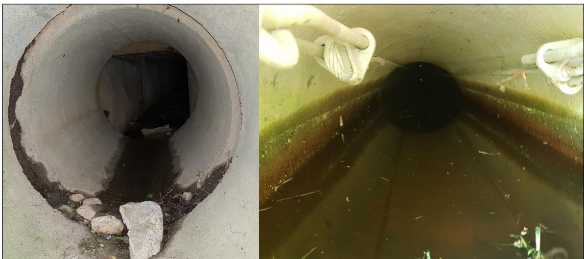
Figur 12. Stentrumma förlängd med betongringar till vänster samt betongtrumma med stående vatten i Östanå till höger. Spända vajrar hjälper till att hålla ihop betongringarna.
