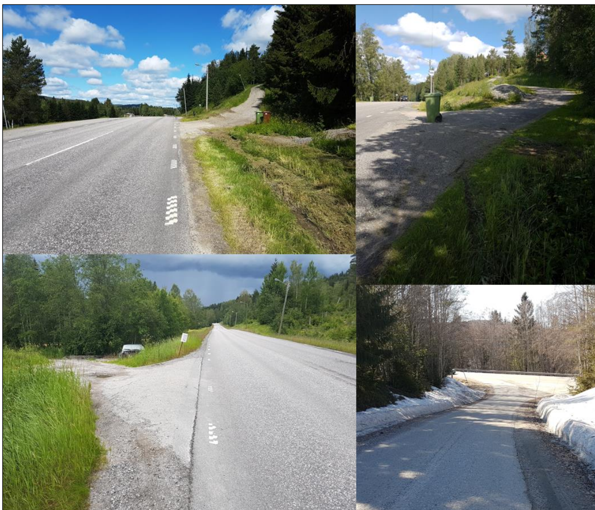
Figur 8. Exempel på branta anslutningar mot väg 86 med snäv korsningsvinkel. Bilden nere till höger visar korsningen med vägen från Tösta fotad från den anslutande vägen mot väg 86.
