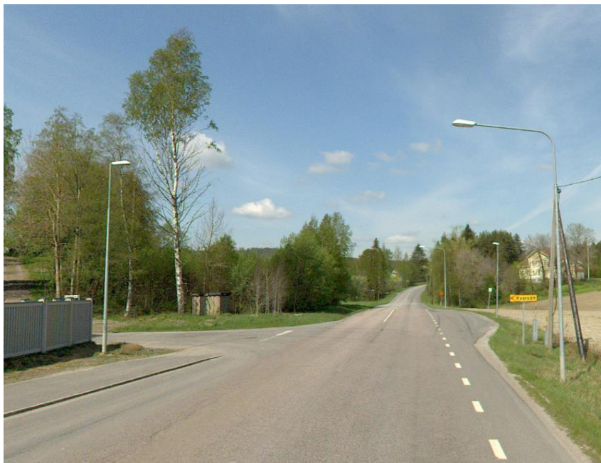
Figur 3. Belysningsstolpar anläggning Y04-86-D. Belysningscentral placerad bakom vägslyt till höger. Foto vid vägplanens södra ände i norrgående riktning. Foto från bilburen laserscanning/geotracker 2019-05-22.
