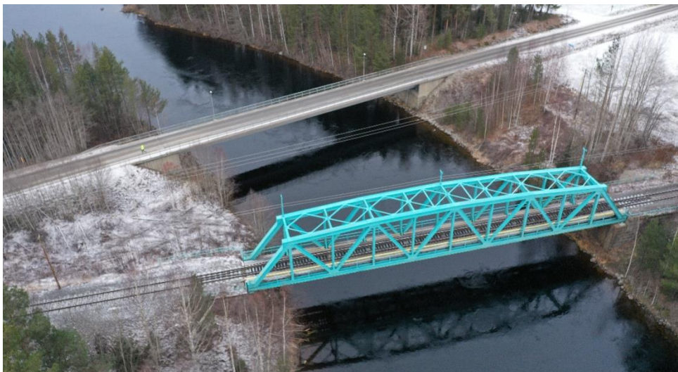
Figur 14. Befintlig väg- och järnvägsbro över Ljungan.
