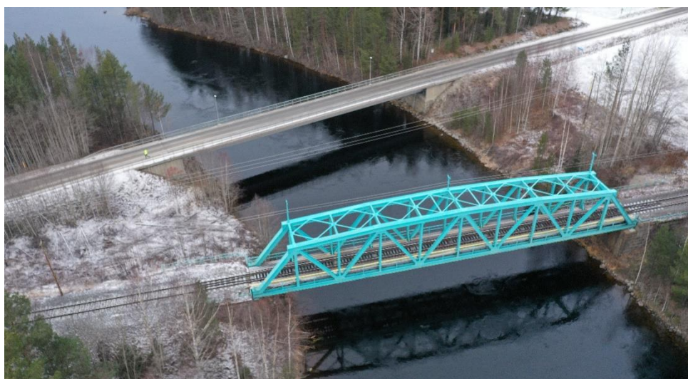
Figur 18. Befintlig väg- och järnvägsbro över Ljungan.
