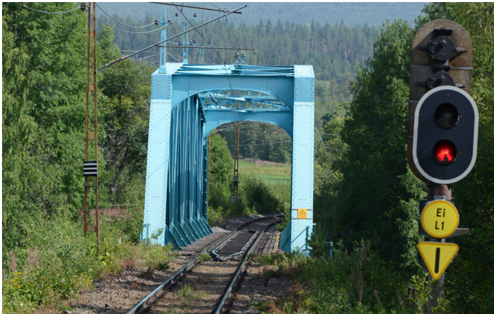
Figur 6 Befintlig järnvägsbro över Ljungan.
