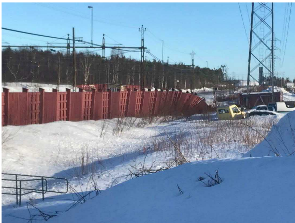
Figur 6. Östlig del av bullerskärm söder om bangården. Skärmen har delvis vält.
