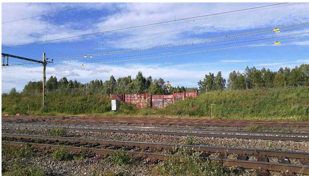
Figur 4. Bullervall med öppningsbar skärm norr om bangården.
