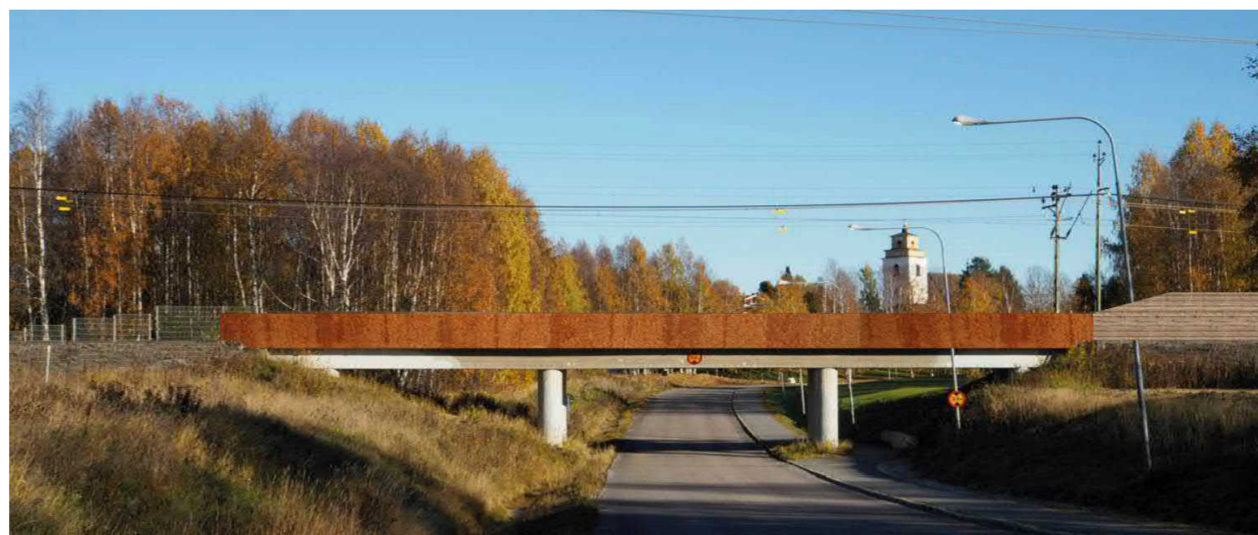
Figur 106. Befintlig vy över järnvägsbro längs Stadsövägen. Vy mot nordost.
