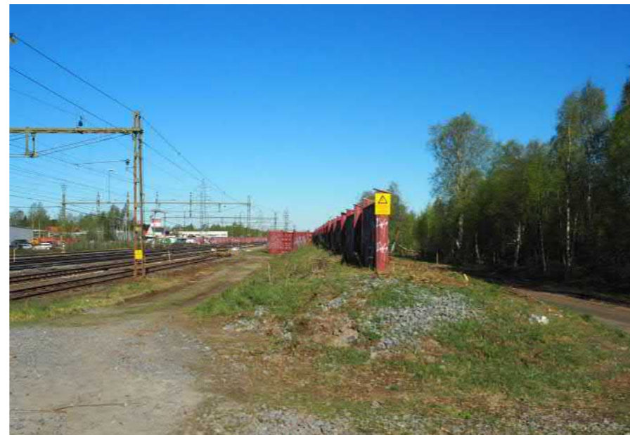
Figur 2. Befintligt bullerskydd längs Malmbanan och Stationsallén. Vy mot nordväst.
