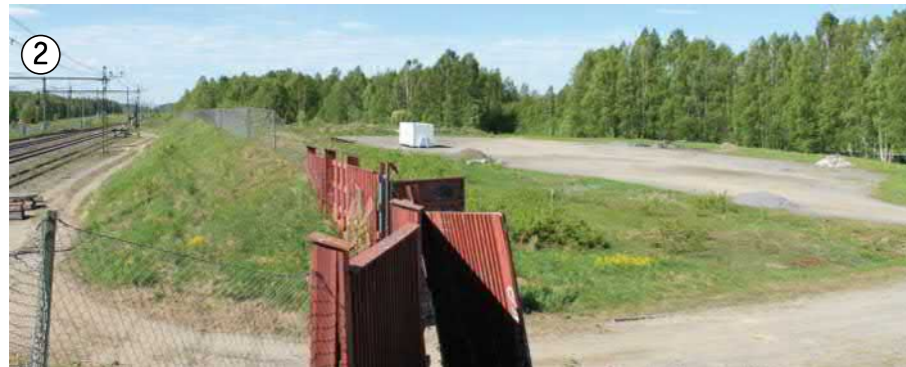
Figur 40. Parkeringsplats norr om järnvägen. I förgrunden syns den tidigare kopplingen (f.d. Stationsbacken) mellan norr och söder.
