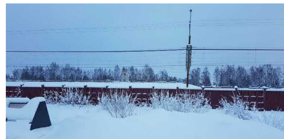
Figur 24. Industri: industriområdet längs järnvägen, vy mot sydväst. Figur 25. Vy över beftintligt byllerskydd och kraftledning, från Hantverkargatan mot nordost. I fonden syns Nederluleå kyrka.
