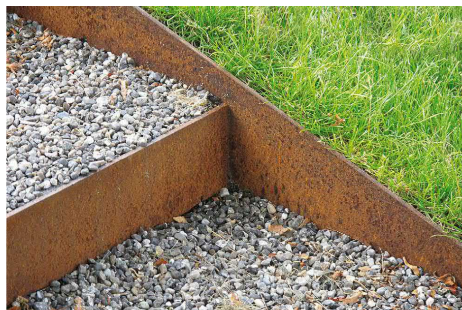
Figur 98. Bildexempel på trappsteg och kant i corten med inslag av grus som möter gräsyta.
