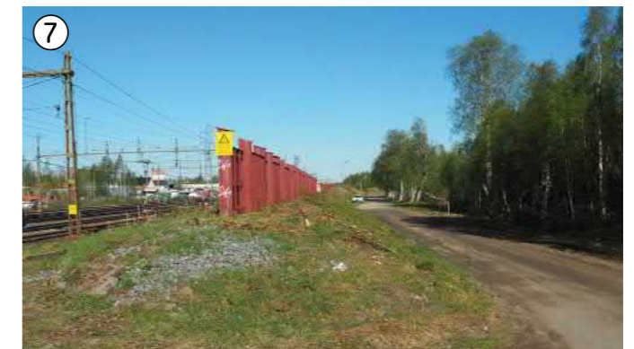
Figur 46. Stationsallén angränsar inte till någon annan väg utan är en återvändsgränd och tar tvärt slut i sydöst. Vy mot nordväst.
