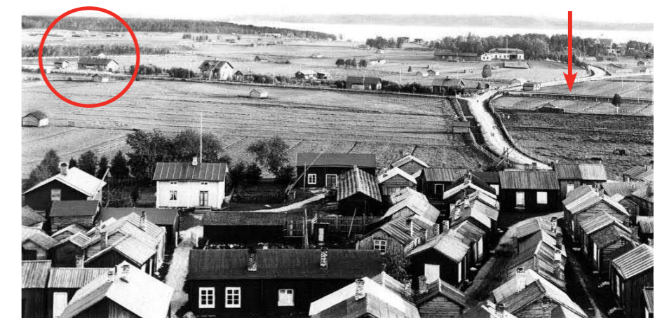
Figur 15. Vy mot sydväst från ca 1910. Vägsträckningen som delar sig till höger är en del av den idag kallade Framlänningsvägen (f.d. Stationsbacken och Gäddviksvägen). Denna koppling mellan Gammelstads kyrkstad och den södra delen av landskapet (mot Luleälven) finns idag inte kvar. Vid den här tiden var landskapet relativt öppet vilket bidrog till fri sikt till och från kyrkbyn. Det tidigare odlingslandskapet är idag präglad av bebyggelse, infrastruktur och uppväxt vegetation. Den röda ringen pekar ut Gammelstads järnvägsstation och den röda pilen visar järnvägens sträckning.
