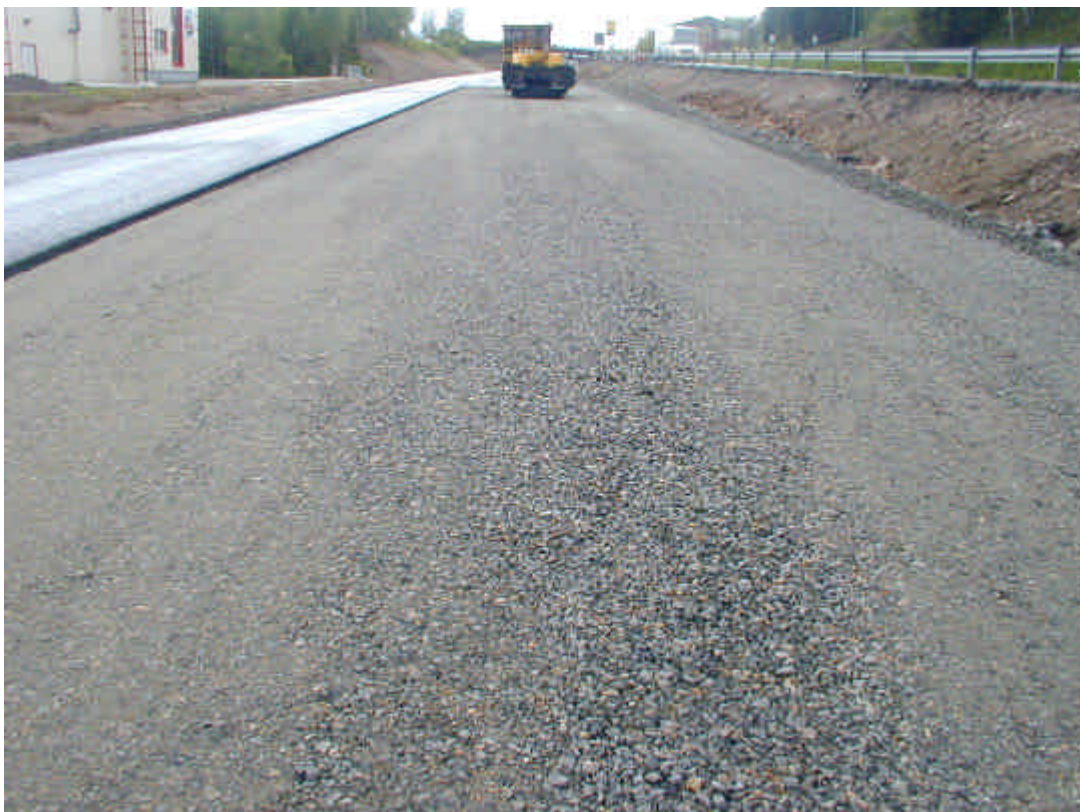
Se upp! Antydning till mittseparation.
