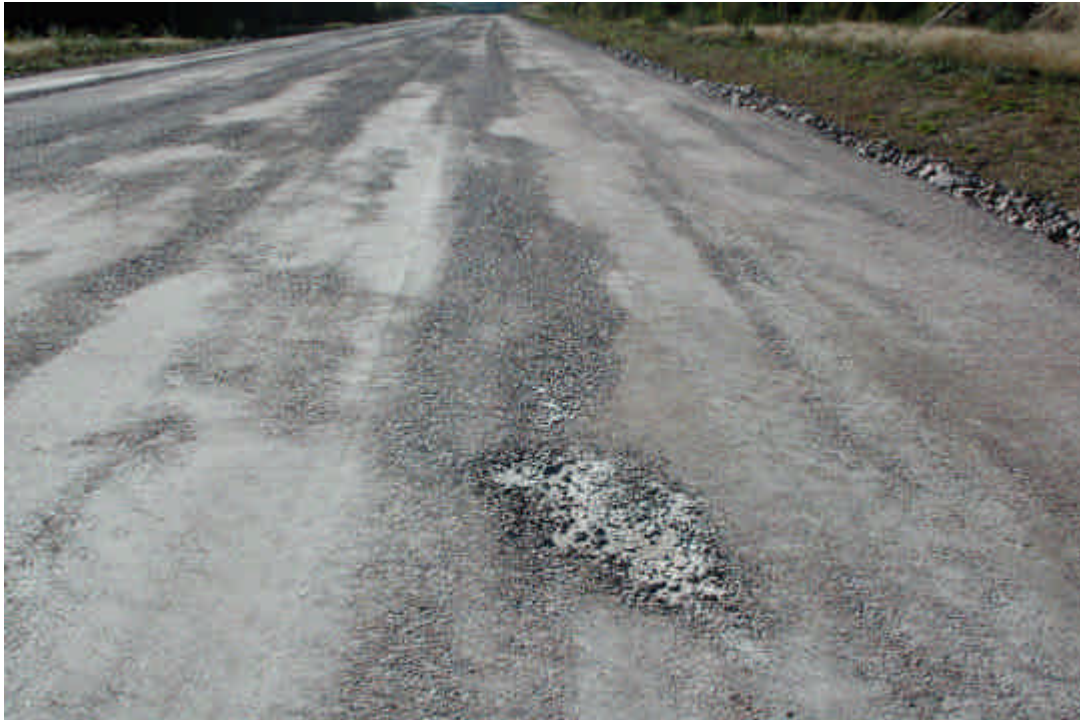
Separation och slaghål!
