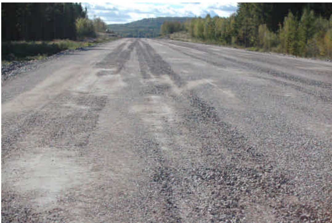
Se upp! Ett färdigpackat och accepterat bärlager skall kontrolleras på nytt om materialet har trafikerats! Undvik att trafikera färdiga ytor!
