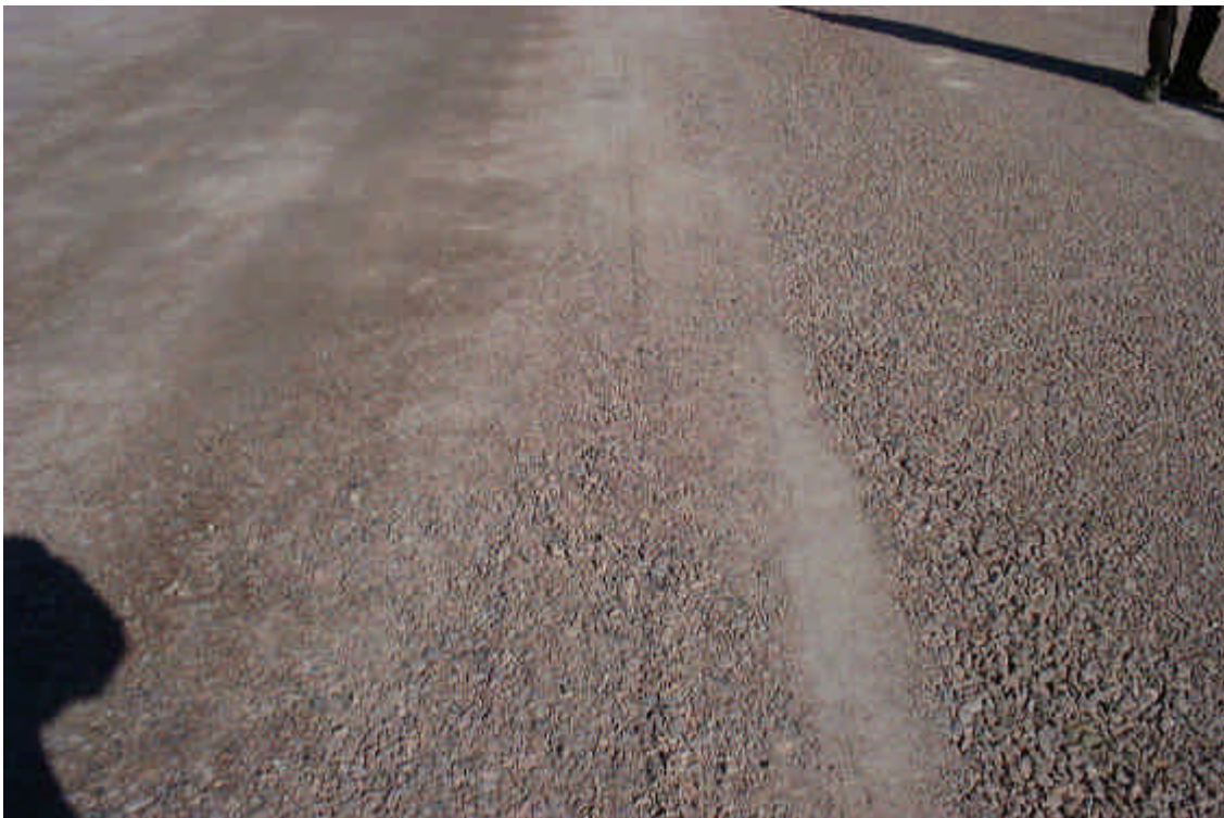
Separationer i bärlagret när det är utlagt. Detta kan ge framtida problem med bärighet, sprick- och spårbildning i asfalten.
