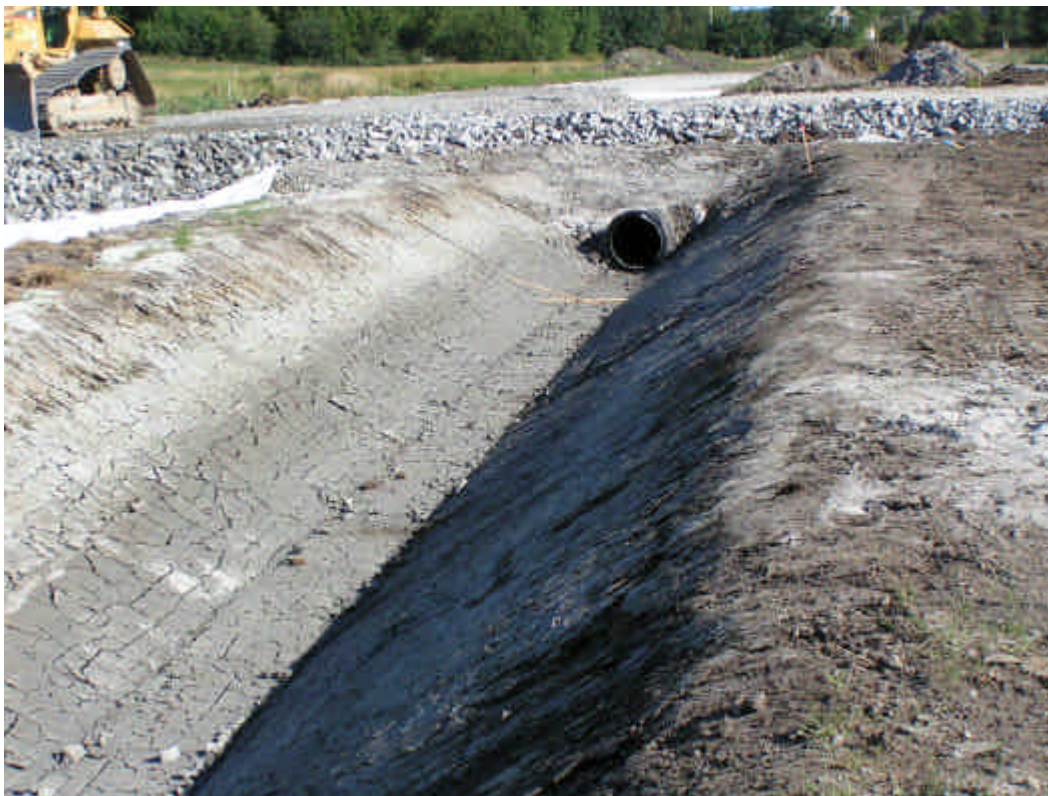
Plastrumma under väg med god fyllningshöjd och ett väl utfört avrinningsdike.
