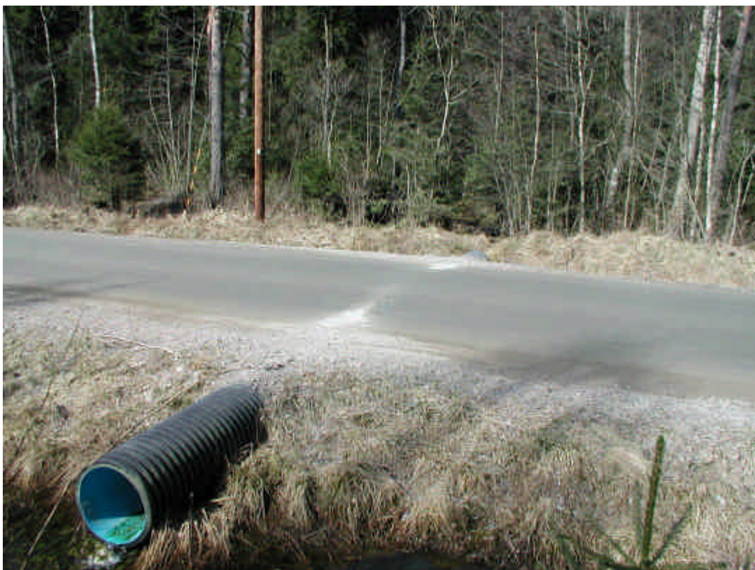
Ny plastrumma under befintlig väg. Fyllning över ledningens eller trummans hjässa skall minst ha den tjocklek (skyddstäckning) som anges i tabell CE/5 i AMA 98.
