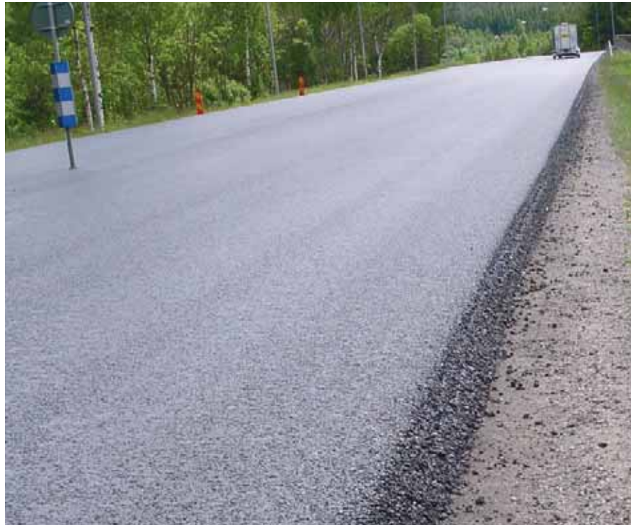
Fel! Sidomarkeringsskärmar saknas som varning för hög kant!
