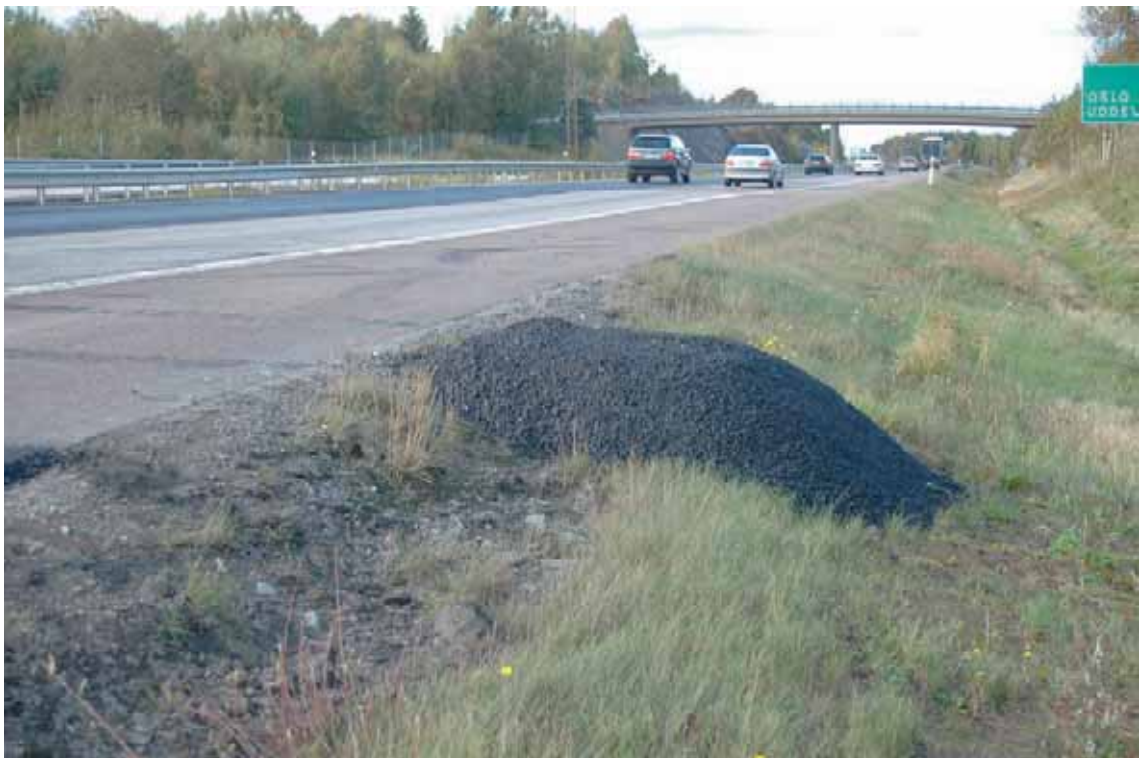
Fel! Töm inte överbliven massa från transportbilarna i diket eller slänten.
