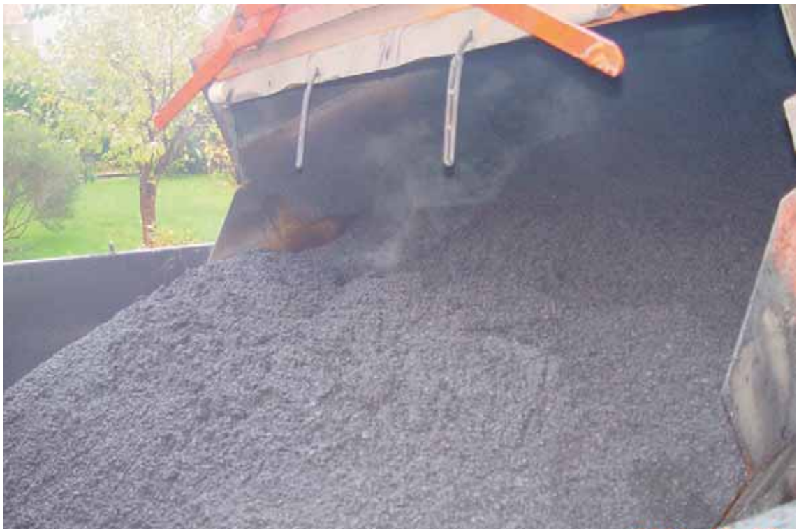
Fel! Flak och lucka ska bilda en trattliknande form. Här fyller bilen tråget på ett felaktigt sätt med avkylning som följd.
