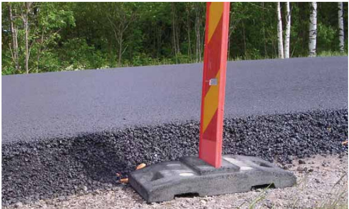
Fel! Sidomarkeringsskärmen skall stå uppe på beläggningen.
