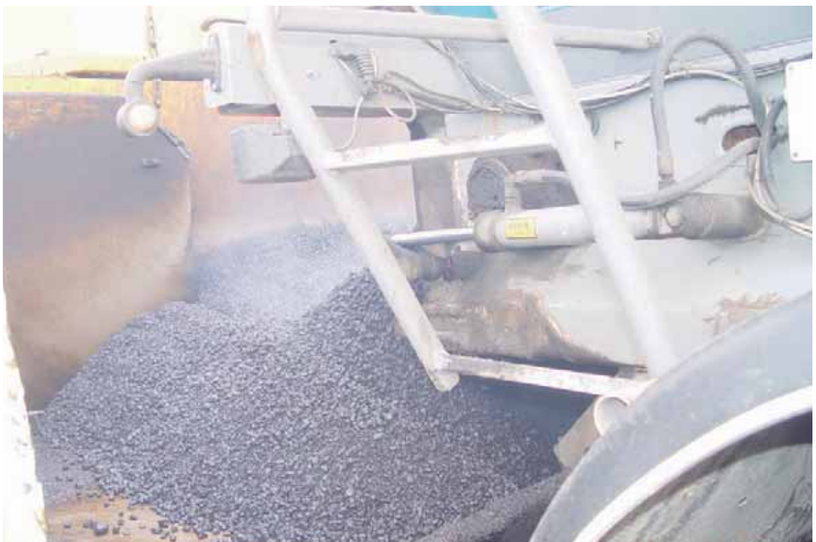
Rätt! Rena fina trågsidor. Asfalten matas direkt till matarbandet från bottenömmare.
