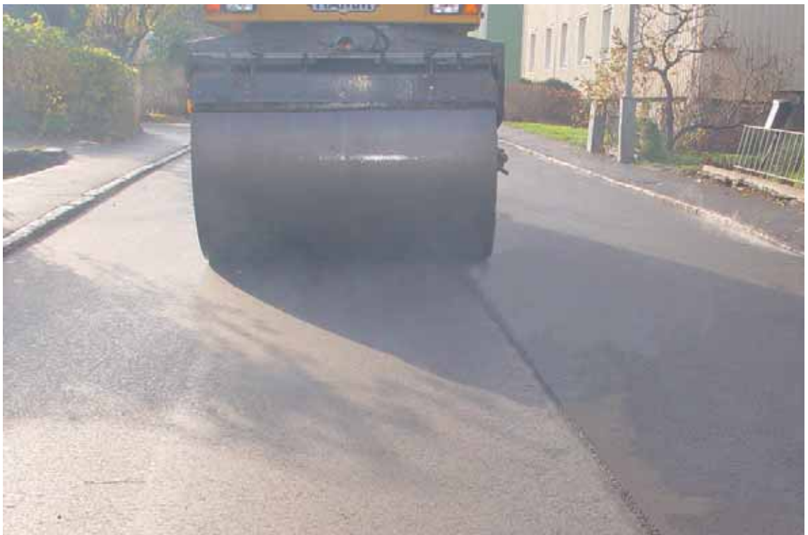
Rätt! Lösa stenar uppsopade och fogen vältas väl.
