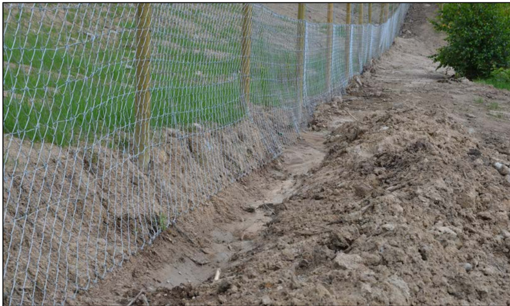
Figur 38. Ett faunastängsel i anläggningsskedet. Faunastängsel sätts runt passagerna 1,2, 5, 6, 7 och 8 för att leda djuren in till dessa passagepunkter.
