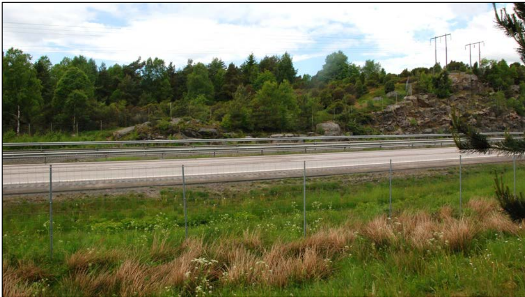
Figur 52. Läge c. Västra sidan med bergsskärningar. Foto taget från östra sidan E6 mot väst.
