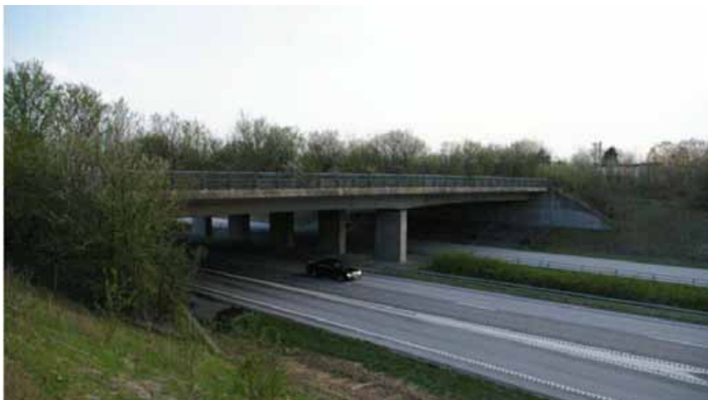
Figur 6:2 Befintlig bro över väg E6 i närheten av ett av de föreslagna lägena för en ekodukt.
