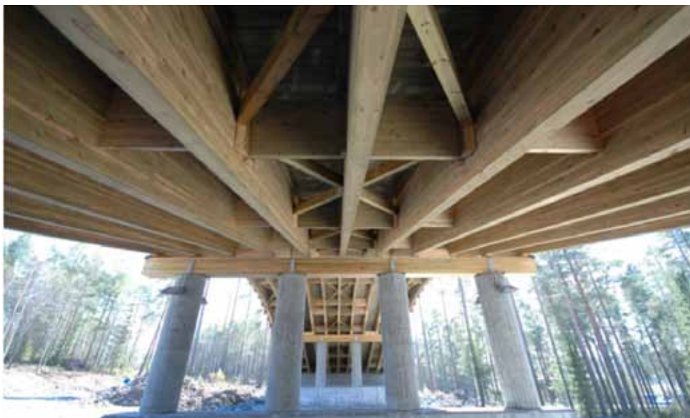
Figur 6:5 Exempel på träbro med huvudbalkar av limträ som lyfts på plats.
