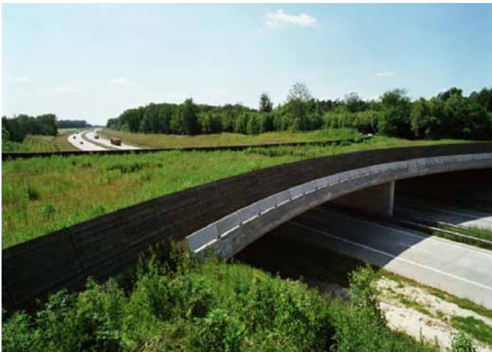
Figur 6:1 Exempel på ekodukt med avskärmning av ljud och ljus från trafiken i form av en träskärm.
