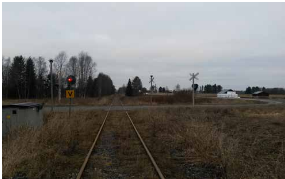
Figur 4.3 Järnvägsspåret som förbinder Inlandsbanan med Strömsund korsas av väg 345.
