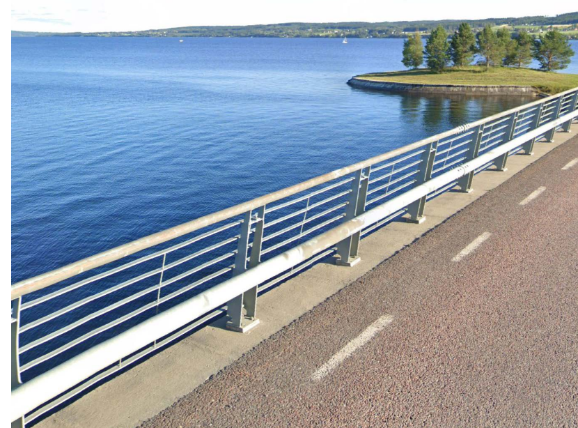
Figur 8. Exempel på broräcke av rörräckestyp med horisontella spjälgrindar. Vallsundsbron Östersund
