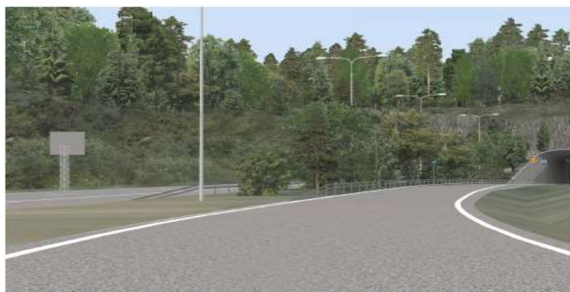
Fig 4.1.02: Vy mot mynning vid Tillflykten, sedd från påfart. Bilden visar stödmurar, bergskärning, mynningsportaler, väg utrustning och vegetationsutbredning av ca 15 år gammal vegetation.
