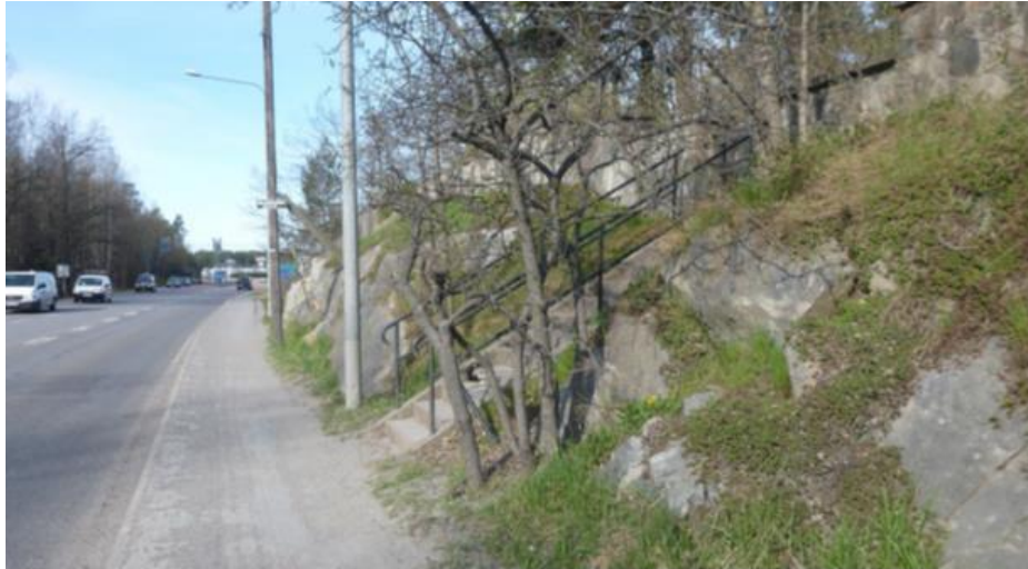
Figur 18 Dagens smala gång och cykelbana på norra sidan av väg 222.
