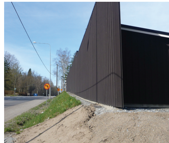
Nyligen uppförd garagebyggnad med bullerskyddsskärm mot väg 222, tillhörande flerfamiljshus, ger en upplevelse av något främmande och hotfullt på grund av sin höjd, mörka kulör och fönsterlösa fasad.
