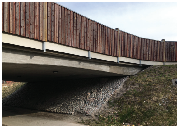
Inspiration bullerskyddsskärm med stående träplankor över öppen gång- och cykeltunnel med lutade, stensatta väggar.
