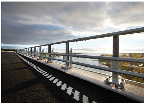
Räcken med olika placering och kapacitet väljs inom en formfamilj. Broar förses med stänkskydd av polykarbonat. (Foto: Saferoad, Birsta 39/H4b)
