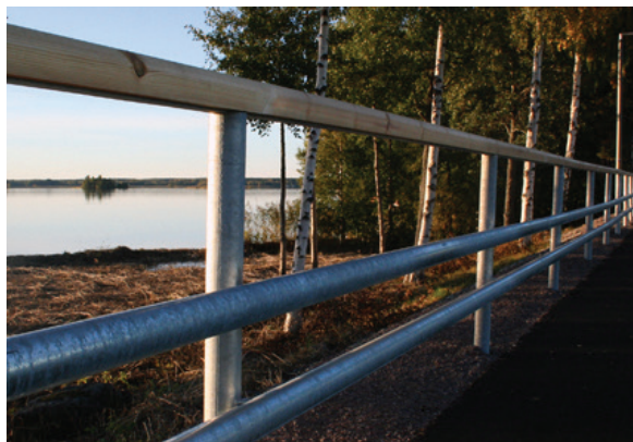
Typ av rörräcke längs kantsten som skiljer GC-bana från körbana. (Foto: Saferoad, Birsta 2P GC specialvariant med överliggare av trä)
