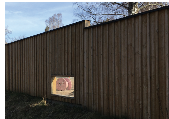
Inspiration bullerskyddsskärm med trälistor och lågt placerade genomskinliga fönster vid förskola i Tyresö.
