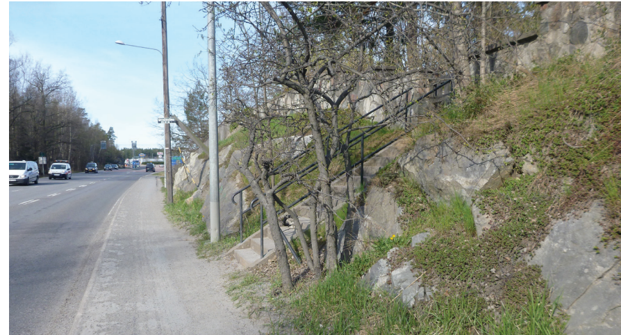
Dagens smala gång- och cykelbana på norra sidan av väg 222.
