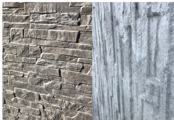
Inspiration prefabricerad stödmur med stående respektive liggande relief/mönster i varm respektive sval kulör.
