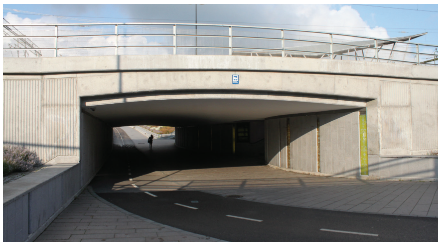
Exempel på rakt ställda vingmurar, låga stödmurar och en linjeföring som leder blicken vidare från passagen. (Foto: Helena Brämerson-Gaddefors)
