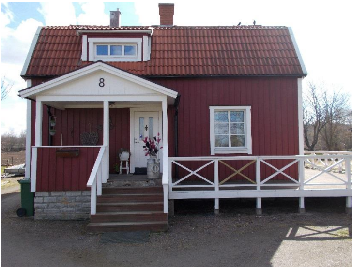
Fasad mot väster. Sid vända mot Simmesgårdsvägen
