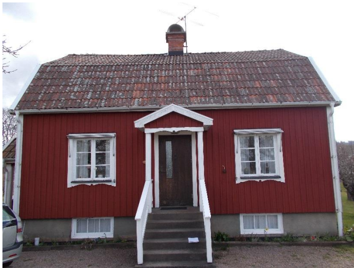
Fasad mot väster. Sida mot Simmesgårdsvägen
