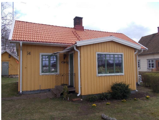
Fasad mot väster. Sida mot Simmesgårdsvägen
