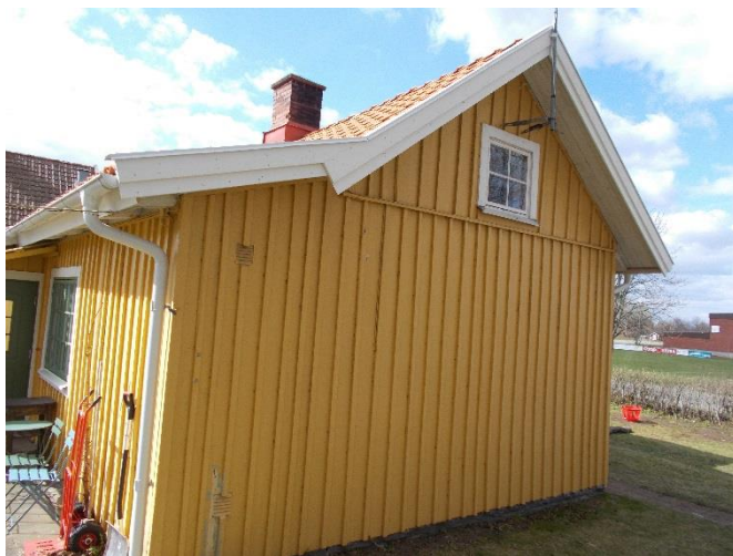
Fasad mot norr. Sida vänd mot väg 49
