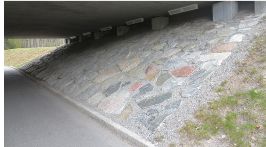
Figur 45. Släntbegräddning av stenblock under bro.
