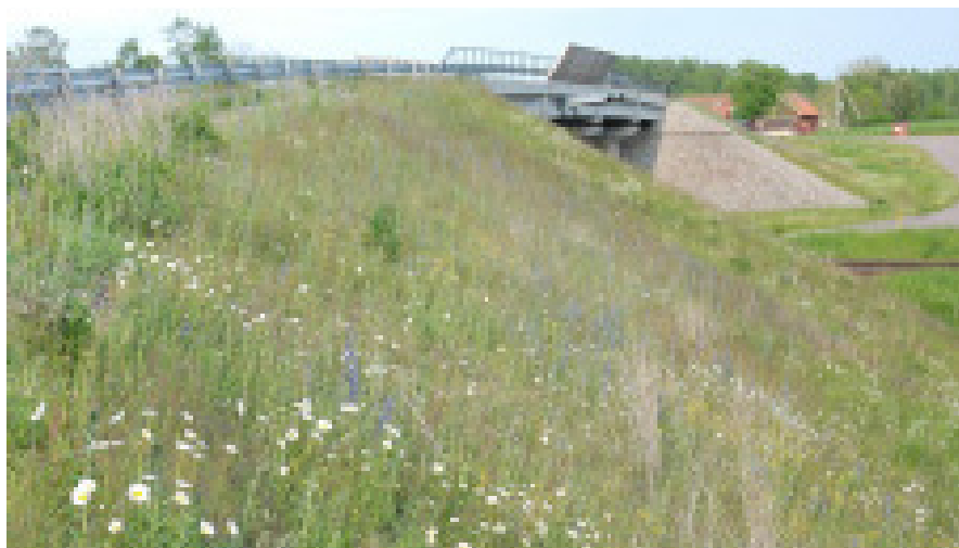
Figur 16. Genom att täcka sidoområden med avbaningsmassor från platsen kan en naturlig flora snabbt etableras. Med regelbunden slåtter kan man skapa blommande vägkanter. Källa: Trafikverket, 2015.
