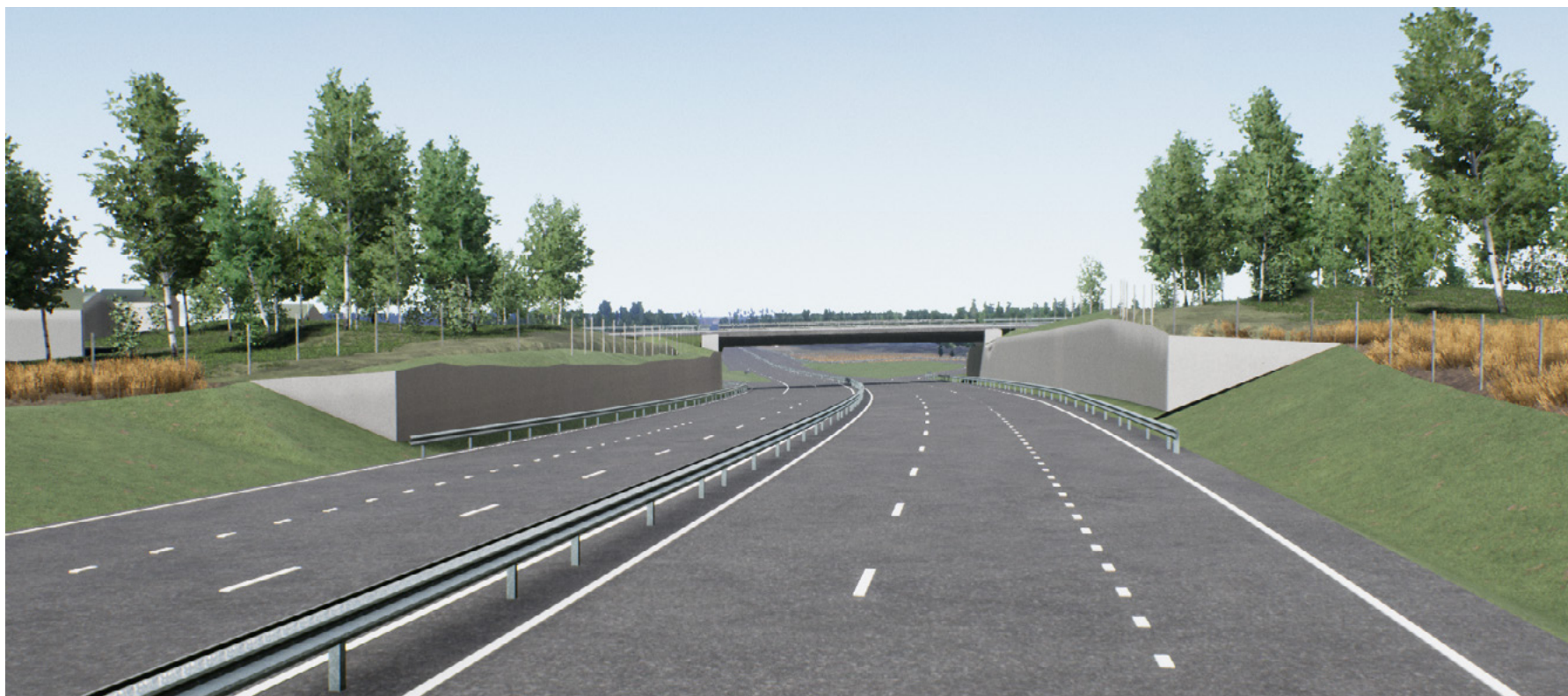
Figur 52. Trafikplats Varnhem österifrån. Stödmurarna möter obemärkt vingmurarna till bron och bidrar till intrycket att det bara gjorts ett snitt i platakanten för väg 49. Obs! Stödmurarna har i verkligheten en jämn ovankant, även om så inte visas i denna bild.
