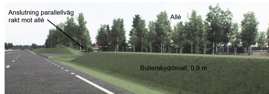
Figur 29. Parallellvägen ansluter väg 49 mellan bullerskyddsvallarna. En allé behöver kortas ner på grund av parallellvägens dragning, medan dess strukturbärande egenskaper förstärks i och med parallellvägens raka anslutning mot denna. Över den låga bullerskyddsvallen kan en trafikant se bakomliggande vegetation, byggnader och bitvis lite mark.
