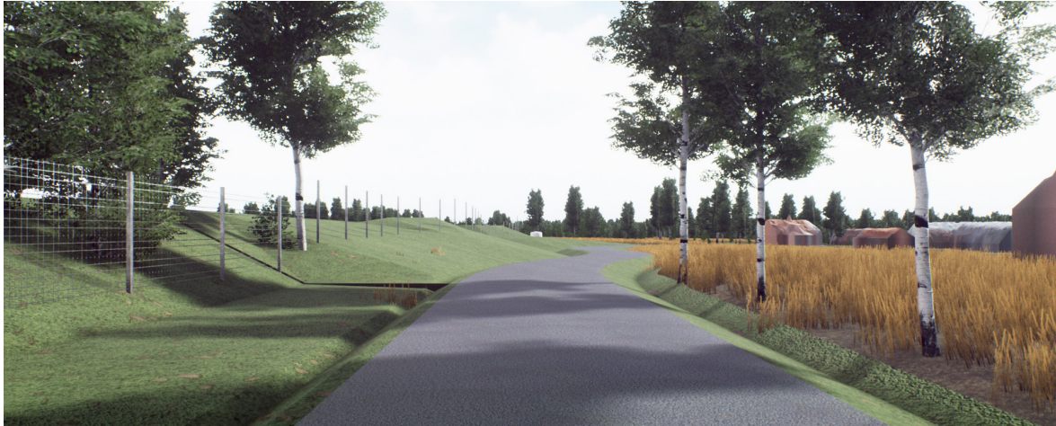
Figur 24. Planteringen av bullerskyddsvallens bakslänt övergår i en landskapsanpassning av topografin i form av ett par kullar som bryter av den långa och raka strukturen av bullerskyddsvallen sett från parallellvägen. Parallellvägen tar stöd i dessa höjdformationer där den viker av söderut. Parallellvägens placering i förhållande till bullerskyddsvall och gc-väg optimeras i byggskede för att undvika impedimentytter och för att göra så litet intrång som möjligt i trädgårdarna.
