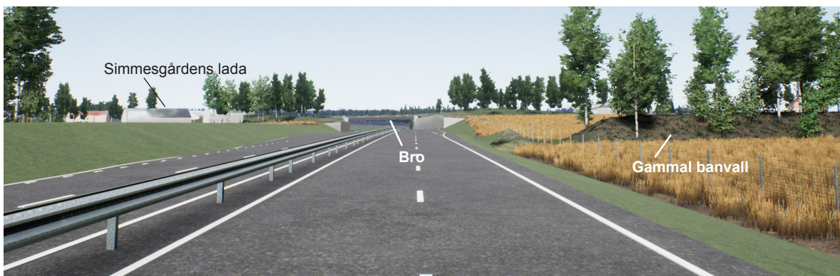
Figur 34. Vägplanens förslag, Varnhem österifrån. Södra delen av den gamla banvallen (på bilden till vänster om vägen) täcks av bullerskyddsvallen. Trafikplatsen blir inte lika framträdande från detta håll som västerifrån.
