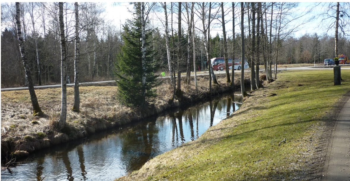
Figur 90. Bäck vid Ökull från norr mot trumma under väg 49.
