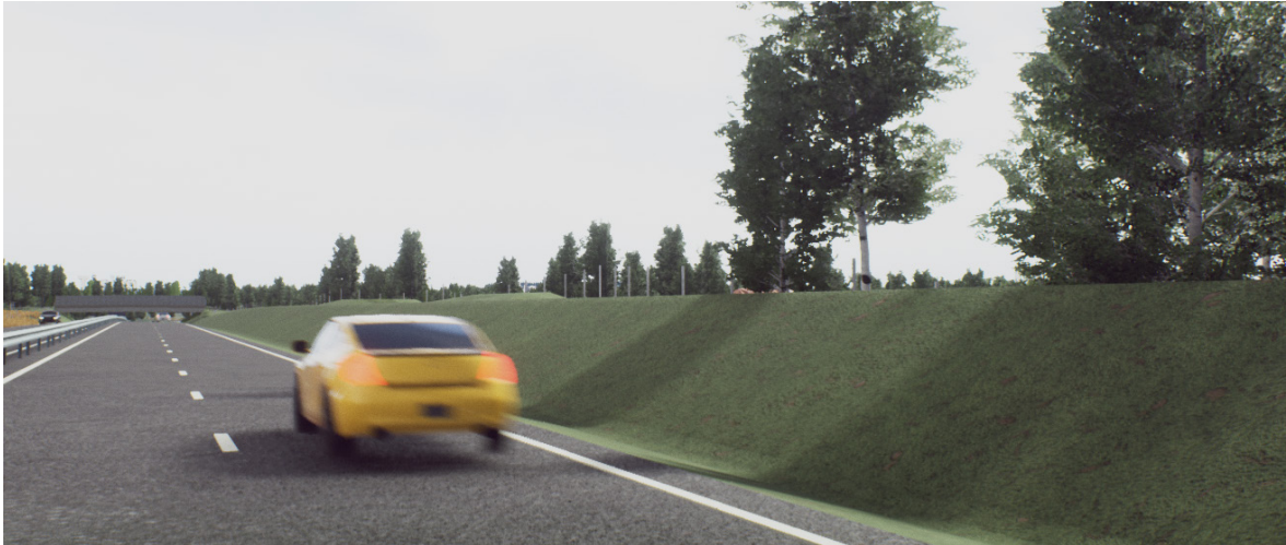
Figur 27. Den cirka två meter höga bullerskyddsvallen täcker det mesta av utsikten söderut från Sjövik och fram till ekodukten. Landskapsanpassningarna som görs av bullerskyddsvallen är tänkta att framhäva småskaligheten som finns på den södra sidan.
