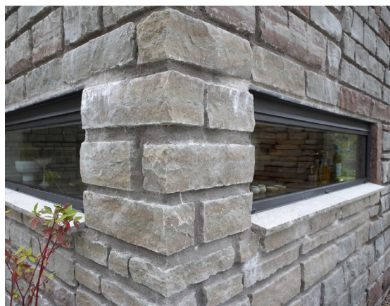
Figur 46. Exempel på beklädnadssten. (Foto: Naturstenskompaniet.)
