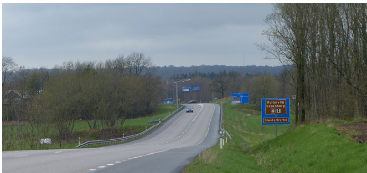
Figur 65. Vy mot Varnhemskorsningen från ostnordost vid Överbo busshållplats. Här kommer väg 49 breddas och sänkas så att den korsande Öglundavägen går på en bro över väg 49. Kanterna mot gravfälten på ömse sidor om vägen föreslås förstärkas med kalkstensmurar.
