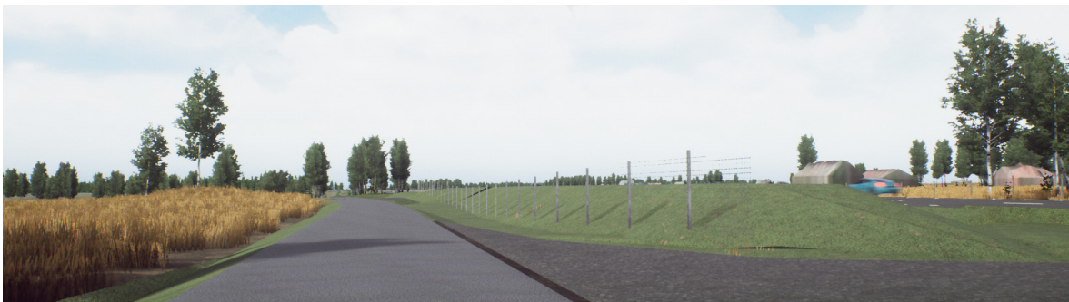
Figur 22. Söderifrån kan en betraktare se vegetation, byggnader och ovandelen av bilar över vallen. Parallellvägen ligger utanför vägområde och uppritad väg är därför bara ett förslag. I nästa skede krävs optimering av gc-banans och parallellvägens dragning.
