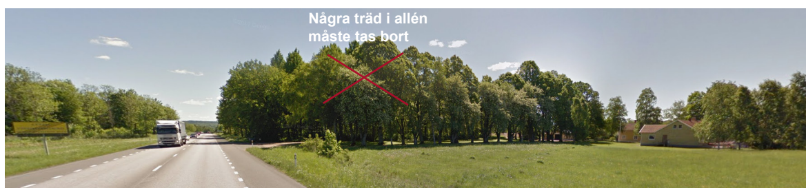
Figur 14. Nuläge, Trafikantperspektiv vid Sjövik före ombyggnad. Parallellvägen kommer att ansluta i samma punkt som infarten till höger i bild. Några träd i allén kommer behöva tas ner.
