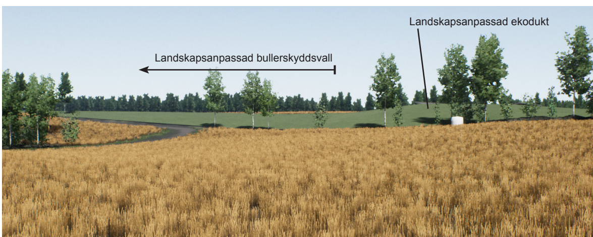
Figur 26. Vägplanens förslag. Utblick norrut från campingen vid Husgårdessjön. Landskapsanpassning kring ekodukt. Vegetation tillkommer på krönet. Landskapsanpassning kring ekodukten övergår i en landskapsanpassad bullerskyddsvall. Vägen ligger här lågt i landskapet, vilket medför att både skog och även en bit mark kan ses över bullerskyddsvallen.
