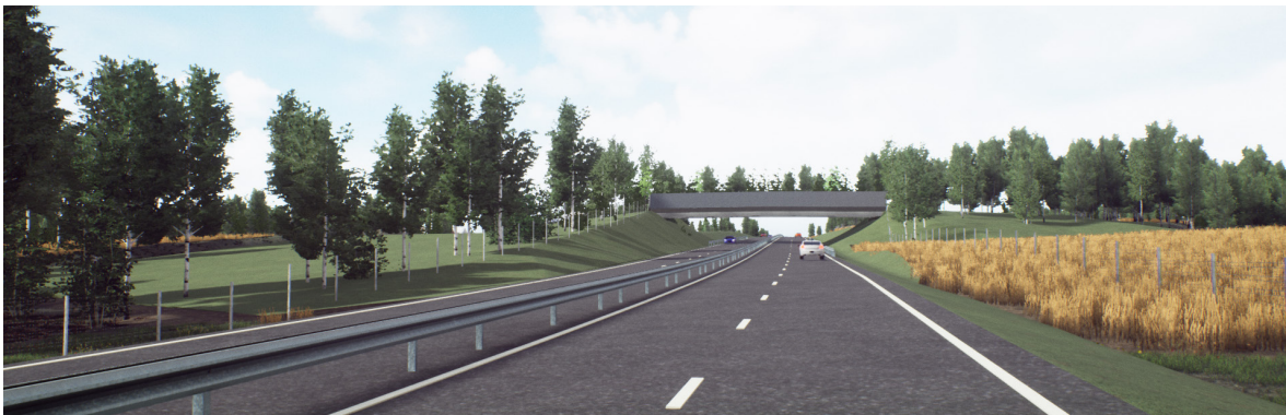
Figur 28. Ekodukten sedd från öster. Landskapsanpassning görs genom att naturliga höjder i landskapet byggs på så att ekoduktens båda ändrar förankras väl i omgivningen.
