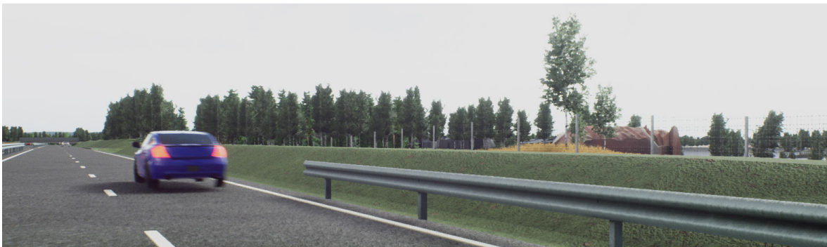
Figur 21. Över den låga bullerskyddsvallen kan en trafikant se strukturerna av bakomliggande vegetation, byggnader och bitvis lite mark. (Observera att modellen inte visar lika mycket och samma typ av vegetation som finns i verkligheten, samt att husen i verkligheten inte är knöliga!)
