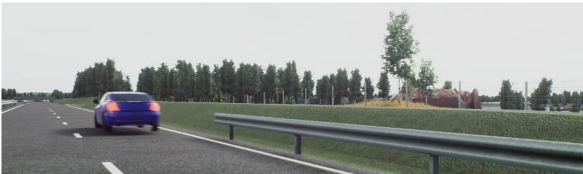
Figur 20. Över den låga bullerskyddsvallen kan en trafikant se strukturerna av bakomliggande vegetation, byggnader och bitvis lite mark. (Observera att modellen inte visar lika mycket och samma typ av vegetation som finns i verkligheten, samt att husen i verkligheten inte är knöliga!)
