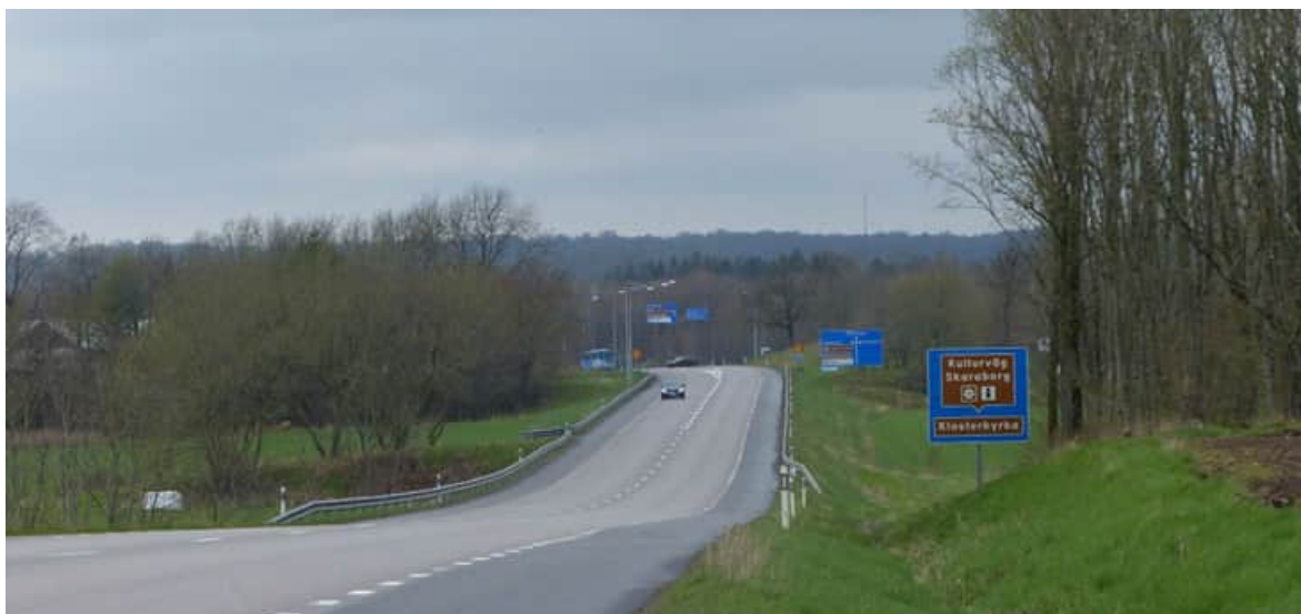
Figur 64. Vy mot Varnhemskorsningen från ostnordost vid Överbo busshållplats. Här kommer väg 49 breddas och sänkas så att den korsande Öglundavägen går på en bro över väg 49. Kanterna mot gravfälten på ömse sidor om vägen föreslås förstärkas med kalkstensmurar.
