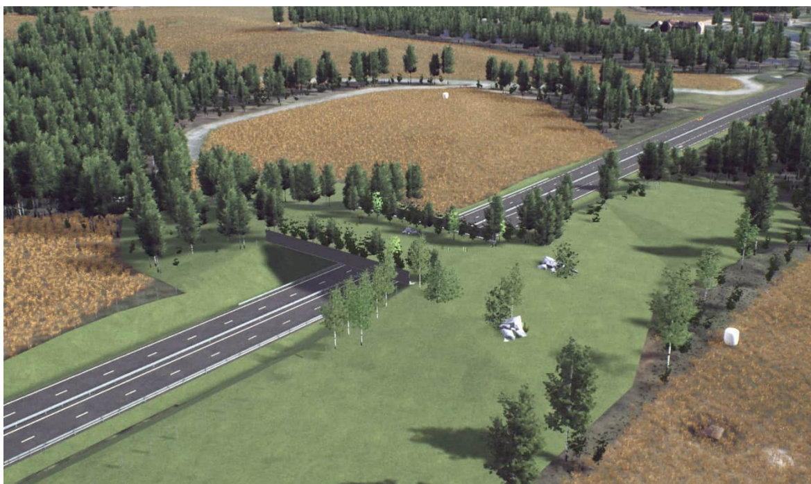
Figur 54. Vy över ekodukt. Lite högre planteringar föreslås längs ekoduktens sidor och några spridda grupper med buskar däremellan. Sikten mitt över ekodukten ska vara fri. Högar av sten och högar av död ved placeras ut på och i anslutning till ekodukten. En blandning av buskar och träd planteras i vinklar ut från ekoduktens skärmar, samt utmed faunastängslet (friavstånd 1 m) mellan ekodukten och skogen i öster. Den enskilda vägen inte visas i bilden, denna framgår av bilagor och illustration.
