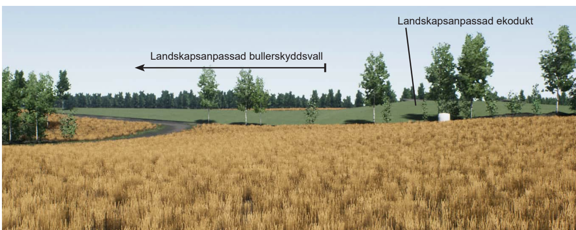
Figur 25. Vägplanens förslag. Utblick norrut från campingen vid Husgårdessjön. Landskapsanpassning kring ekodukt. Vegetation tillkommer på krönet. Landskapsanpassning kring ekodukten övergår i en landskapsanpassad bullerskyddsvall. Vägen ligger här lågt i landskapet, vilket medför att både skog och även en bit mark kan ses över bullerskyddsvallen.
