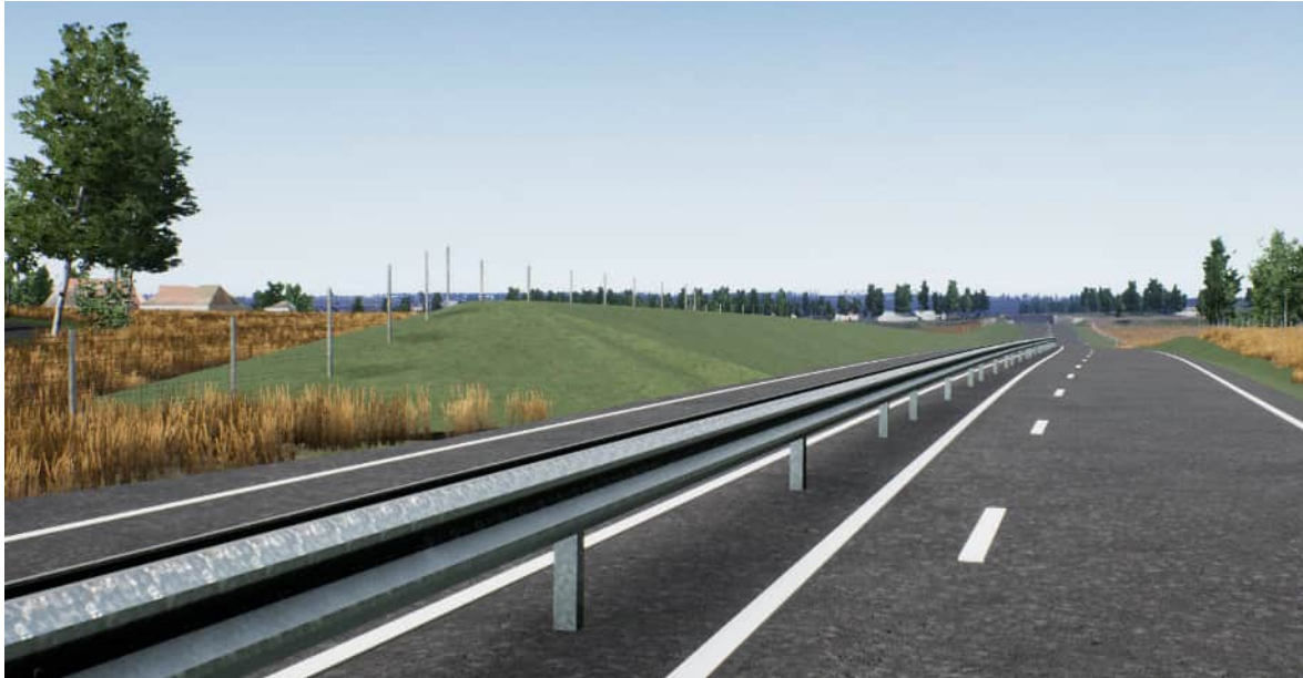
Figur 40. Bullerskyddsvallen sedd österifrån. Varnhem syns till vänster. Faunastängslet är placerat strax bakom vallens krön, sett från vägen.
