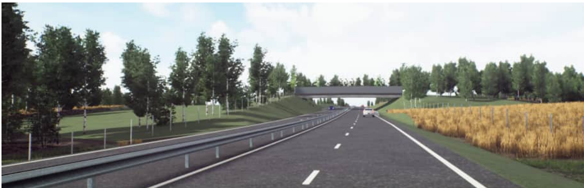
Figur 27. Ekodukten sedd från öster. Landskapsanpassning görs genom att naturliga höjder i landskapet byggs på så att ekoduktens båda ändar förankras väl i omgivningen.
