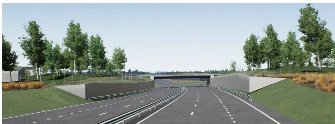
Figur 28. Trafikplats Varnhem österifrån. Trafikplats Varnhem österifrån. Stödmurar och brons vingmurar utförs som en enhet. Observera att stödmurarna ska utformas med jämn överkant, även om så inte visas i denna bild.
