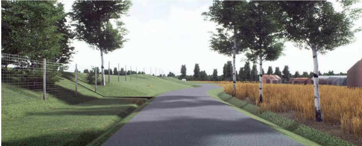
Figur 23. Planteringen av bullerskyddsvallens bakslänt övergår i en landskapsanpassning av topografin som bryter av den långa och raka strukturen av bullerskyddsvallen sett från parallellvägen. Parallellvägen tar stöd i dessa höjdformationer där den viker av söderut.
