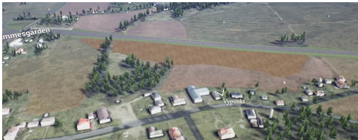
Figur 42. Vy över bullerskyddsvall öster om trafikplats Varnhem.
