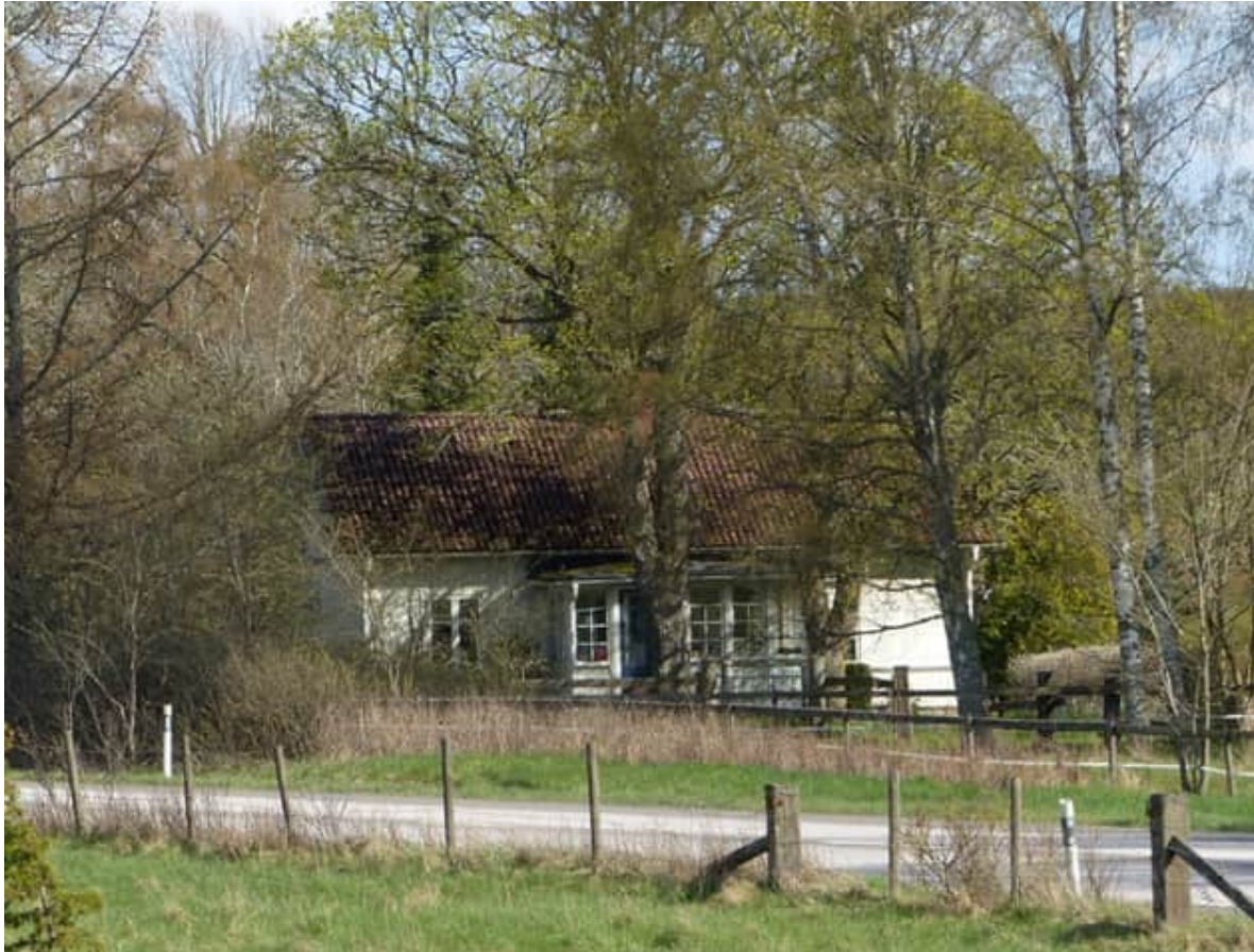
Figur 56. Rospiggstorp med en glasad veranda, söder om väg 49 öster om Axevalla hed. Torpet är den enda byggnad som kommer behöva rivs.
