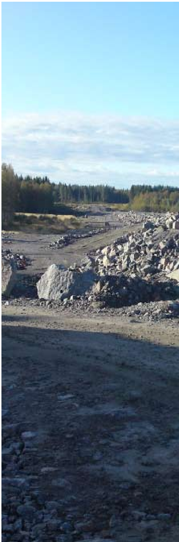
Figur 6.10 Foto påverkan från byggnation nya väg E4, Mörtsjö. 92 Förstudie Gävle - Sundsvall
