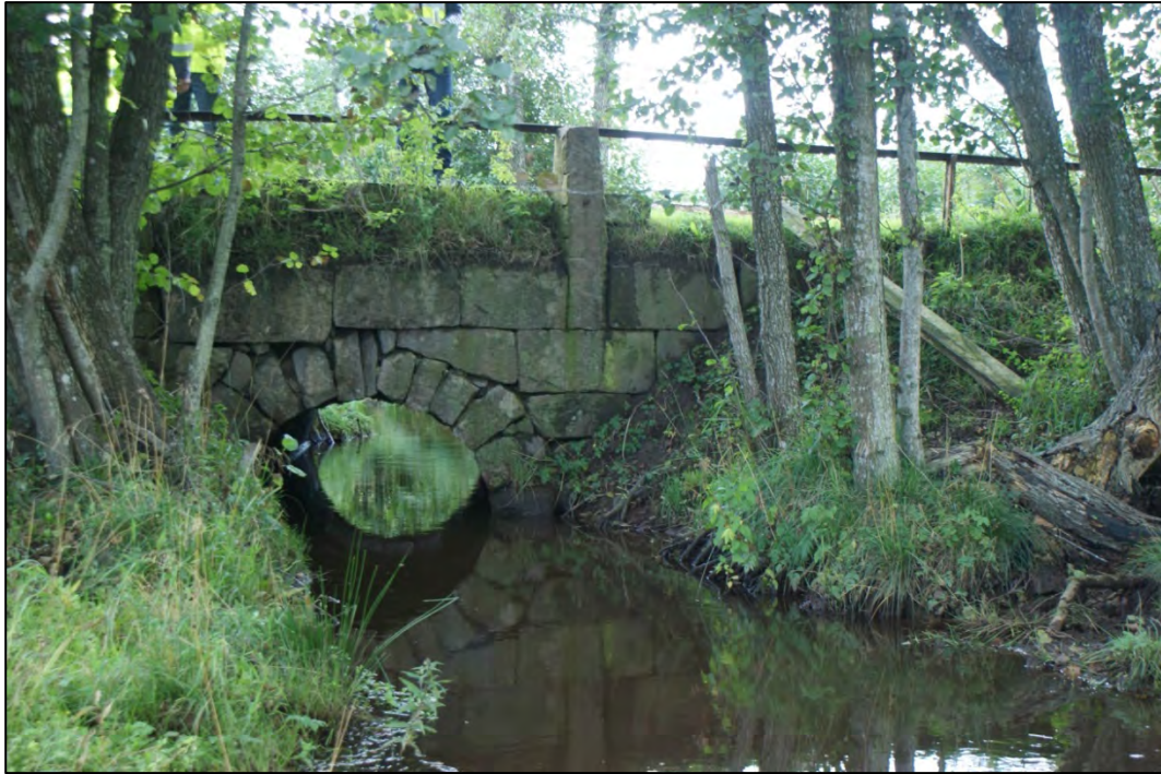
Figur 12 Märskabäcken som passerar under en gammal stenvalvsbro, nedströms E20
