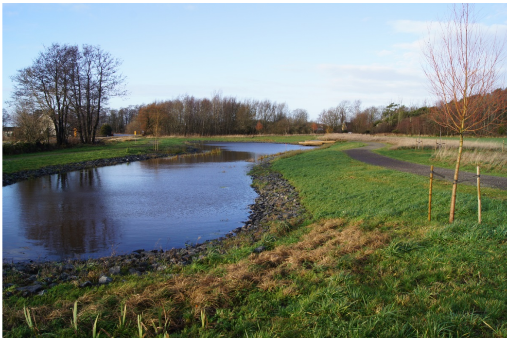
Mjukt böljande dagvattendamm med våtväxter som renar vägdagvattnet.
